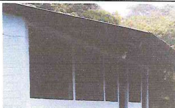
Foto 4: Reparación y pintura de balcones de la escuela
