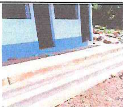
Foto 5: Construcción de tres gradas
