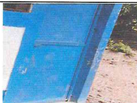
Foto 12: Reparación, pintura y cambio de chapa de puertas de aula y bodega.
