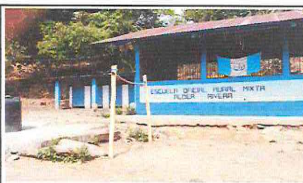
Foto 16: Reparación de fosa séptica.
