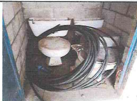
Foto 8: Sustitución de Baños
