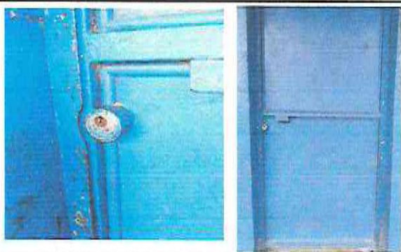
Foto 13: Puerta de aula repación, pintura y cambio de chapa.
