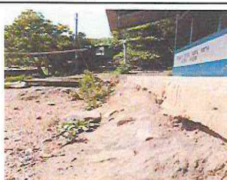
Foto 4: Construcción de 3 gradas de 9mts de largo por 0.30 cm de ancho por 0.25 de alto.
