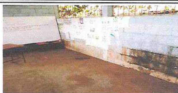
Foto 2: Cambio de torta a cerámica en aula 7x7 mts 49 mts
