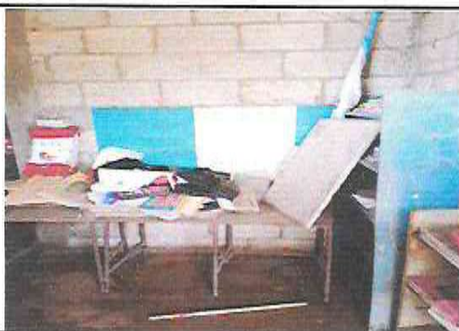
Foto 9: Cambio de torta de cemento por cerámica de bodega.
