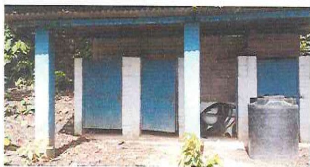
Foto 11: Reparación, pintura de puertas de baños de 1.50 mts por 0.80 cm
