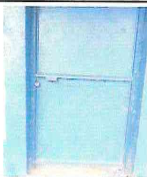
Foto 17: Pintura y reparación de puerta de aula
