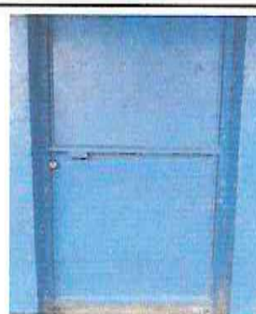
Foto 18: Pintura y reparación de puerta de bodega
