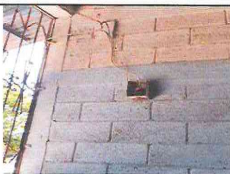
Foto 5: Instalación de caja de flippers
