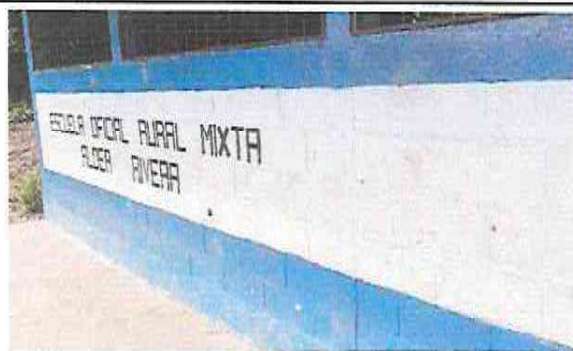
Foto 3: Pintura de interiores de la escuela
