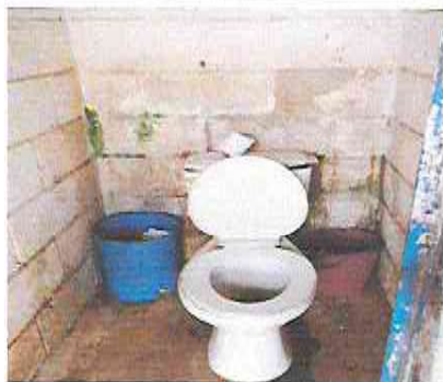
Foto 7: Pintura de baños
