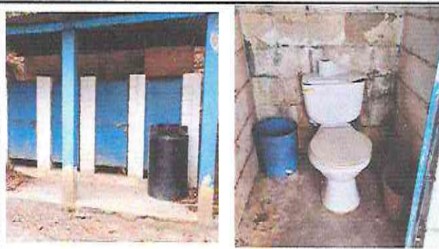
Foto 14: Reparacion y pintura de baños.
