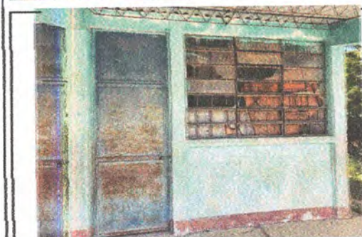
FOTO 9: Pintura y restauración de ventanal en dirección
