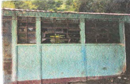
FOTO 8: Pintura y restauración de ventanal en bodega
