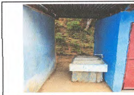
FOTO 12: Instalación de pila de concreto en área de baños.
