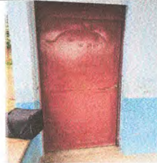
FOTO 4: Sustitución de puertas en aulas.
