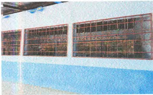
FOTO 3: Mantenimiento y reconstrucción de balcones en aulas.
