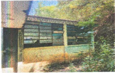
FOTO 1: Pintura de muros en Bodega.
