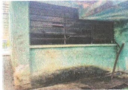
FOTO 6: Reconstrucción de balcon en cocina.
