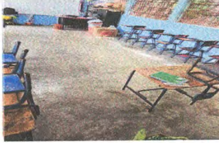
FOTO 2: Instalación de piso cerámico mate en aulas.
