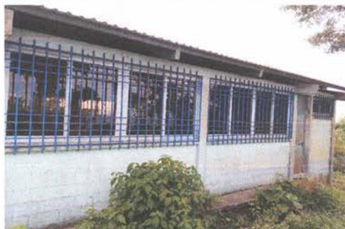
PINTURA EN MUROS INTERIORES Y EXTERIORES
