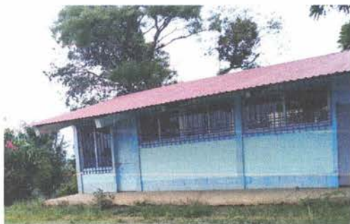
SUSTITUCIÓN DE LÁMINA TROQUELADA ALUZINC CALIBRE 26
