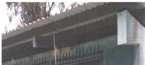
SUSTITUCIÓN DE ESTRUCTURA DE SOPORTE DE MADERA, POR METAL
