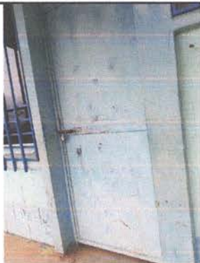
MANTENIMIENTO A ESTRUCTURA DE PUERTAS DE METAL
