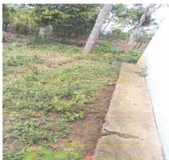
FABRICACIÓN DE CUNETA DE CONCRETO
