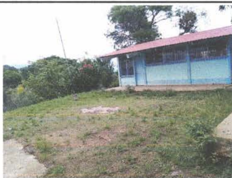
SUSTITUCIÓN DE TORTA DE CONCRETO
