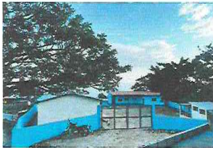
Foto 1: Repello, cernido y pintura en muros interiores y exteriores e instalación de portones
