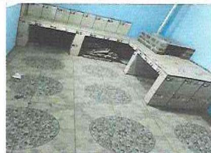
Foto 6: Sustitución de piso de torta de concreto por piso cerámico antideslizante
