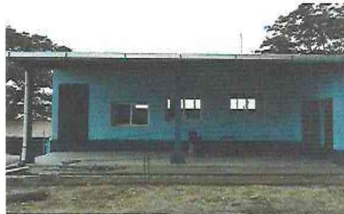
Foto 10: Pintura en muros interiores y exteriores
