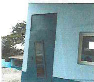
Foto 9: Mantenimiento a puertas de metal (Incluye cepillado, lijado y aplicación de pintura)
