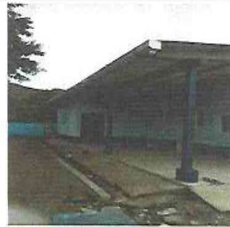
Foto 2: Reparación de estructura de costanera (En la base de muros y el ensamble la lámina de la parte frontal, incluye 20 mts de lámina troquelada calibre 26)
