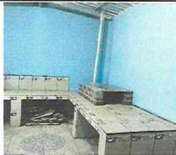
Foto 5: Sustitución de estufa rural completa (incluye polletón, plancha y chimenea)
