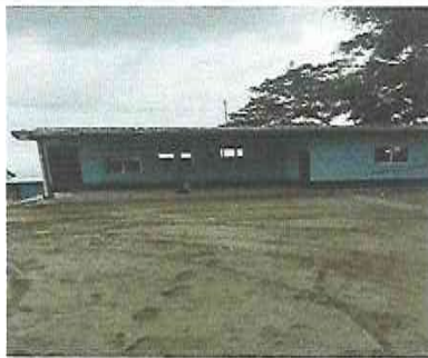
Foto 3: Reparación de estructura de costanera (En la base de muros y el ensamble la lámina de la parte frontal, incluye 20 mts de lámina troquelada calibre 26)
