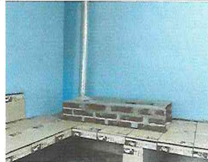
Foto 4: Sustitución de estufa rural completa (incluye polletón, plancha y chimenea)
