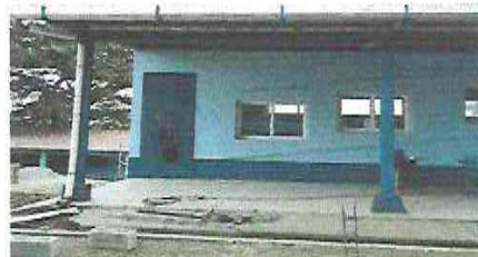
Foto 8: Reparación de estructura de costanera (En la base de muros y el ensamble la lámina de la parte frontal, incluye 20 mts de lámina troquelada calibre 26)
