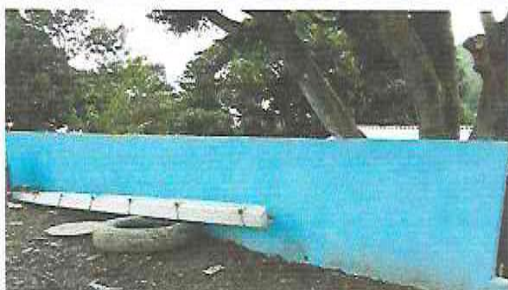
Foto 11: Repello, Cernido y pintura en el muro perimetral
