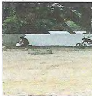
Foto 8: Cernido y pintura en el muro perimetral
