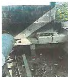
Foto 27: Sustitución de estufa rural completa (incluye polletón, plancha y chimenea)
