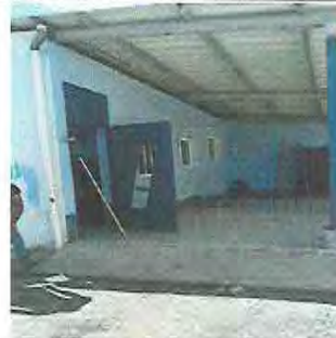
Foto 12: Pintura en muros interiores y exteriores
