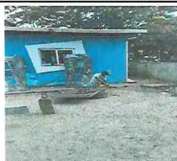
Foto 16: Mantenimiento a puertas de metal (Incluye cepillado, lijado y aplicación de pintura)
