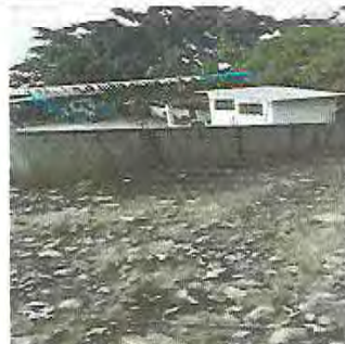
Foto 26: Aplicación de repello, cernido y pintura en paredes del muro perimetral
