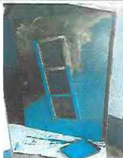
Foto 19: Mantenimiento a puertas de metal (Incluye cepillado, lijado y aplicación de pintura)
