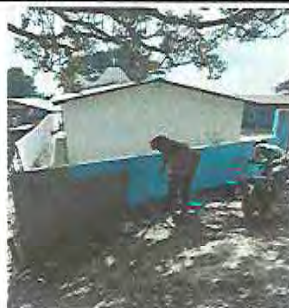
Foto 5: Pintura en muros interiores y exteriores
