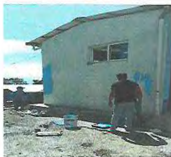
Foto 9: Pintura en muros interiores y exteriores
