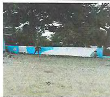
Foto 10: Cernido y pintura en el muro perimetral
