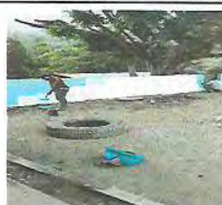
Foto 6: Pintura en muros interiores y exteriores
