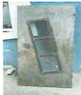
Foto 14: Mantenimiento a puertas de metal (Incluye cepillado, lijado y aplicación de pintura)
