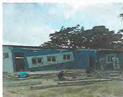
Foto 17: Reparación de estructura de costanera (En la base de muros y el ensamble la lámina de la parte frontal, incluye 20 mts de lámina troquelada calibre 26)
