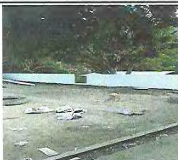
Foto 13: Cernido y pintura en el muro perimetral
