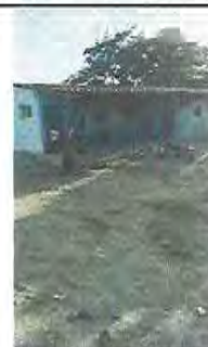
Foto 2: Pintura en muros interiores y exteriores
