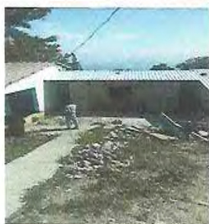
Foto 21: Sustitución de lámina por lámina troquelada calibre 26 aluzinc
