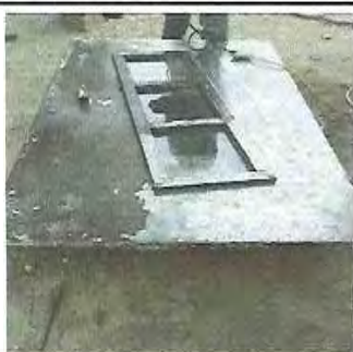
Foto 15: Mantenimiento a puertas de metal (Incluye cepillado, lijado y aplicación de pintura)
