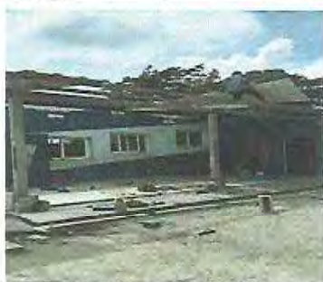
Foto 11: Reparación de estructura de costanera (En la base de muros y el ensamble la lámina de la parte frontal, Incluye 20 mts de lámina troquelada calibre 26)
