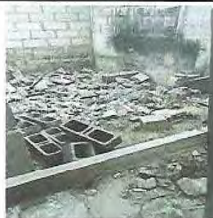
Foto 24: Sustitución de piso de torta de concreto dañado por piso cerámico
