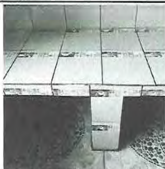
Foto 1: Suministro e instalación de azulejo a mesa de trabajo en el area de cocina
