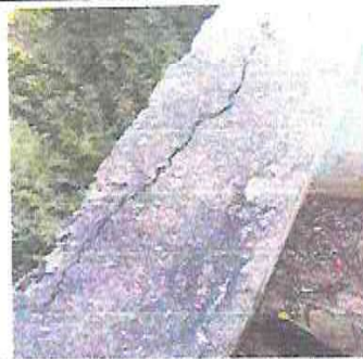
FOTO 8: MANTENIMIENTO DE MURO PERIMETRAL DE BLOCK (REPELLO, CERNIDO Y PINTURA)
