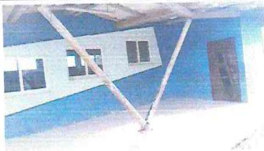
FOTO 13: REPARACIÓN DE ESTRUCTURA DE COSTANERA (EN LA BASE DE MUROS Y EN EL ENSAMBLE DE LA LÁMINA DE LA PARTE FRONTAL, INCLUYE 20 Mts2 DE LÁMINA TROQUELADA CALIBRE 26 YA QUE POR EL DISEÑO SE FILTRA EL AGUA)
