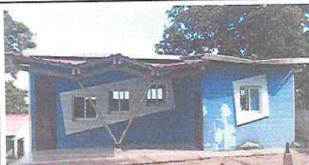
FOTO 14: REPARACIÓN DE ESTRUCTURA DE COSTANERA (EN LA BASE DE MUROS Y EN EL ENSAMBLE DE LA LÁMINA DE LA PARTE FRONTAL, INCLUYE 20 Mts2 DE LÁMINA TROQUELADA CALIBRE 26 YA QUE POR EL DISEÑO SE FILTRA EL AGUA)
