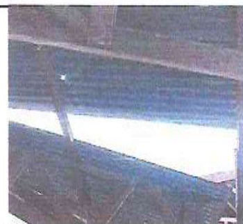
Foto 12: Sustitución de lámina por lámina trequelada aluzinc calibre 26
