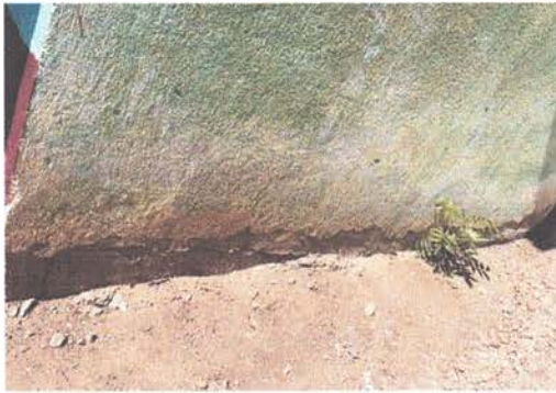
Foto 1: Pintura en muros exteriores e interiores
