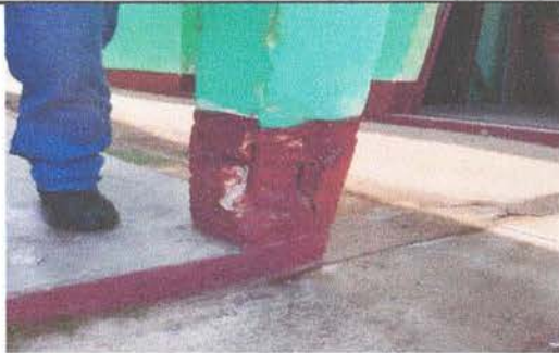
Reparación de piso de torta de concreto
