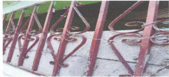
Sustitución de metal de ventana
