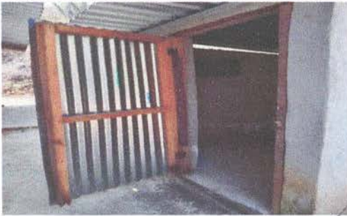
Sustitución de puerta
