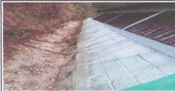
Repello y cernido en muro
