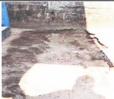
SUSTITUCIÓN DE PISO DE TORTA DE CONCRETO
