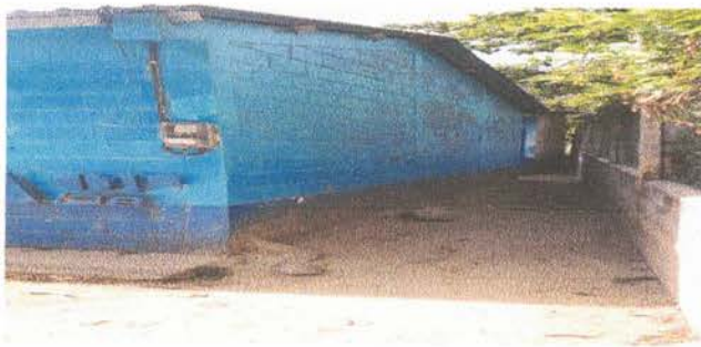
Pintura en Muro exterior e Interior
