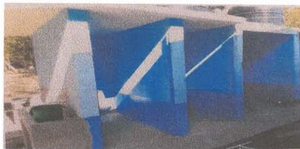
Mantenimiento de Puertas en Sanitarios
