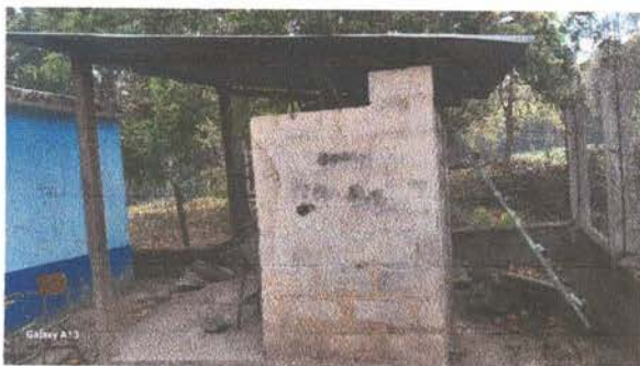
Cubierta De Lámina Y Estructura de Metal
