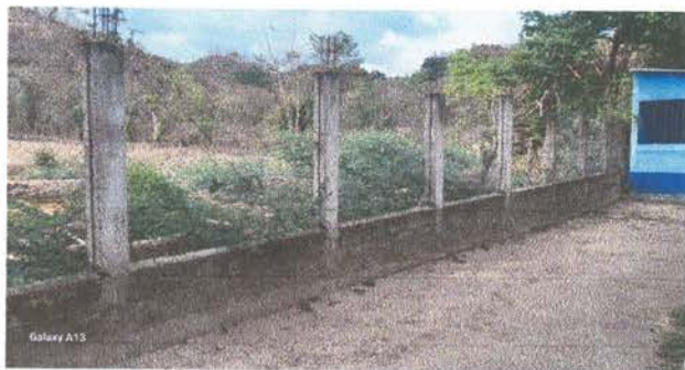
Reparación de Muro Perimetral
