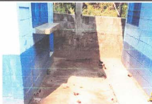
SUSTITUCIÓN DE PISO DE TORTA DE CONCRETO
