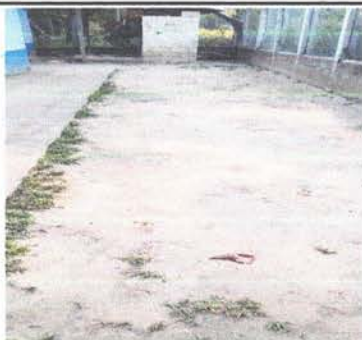
SUSTITUCIÓN DE PISO DE TORTA DE CONCRETO
