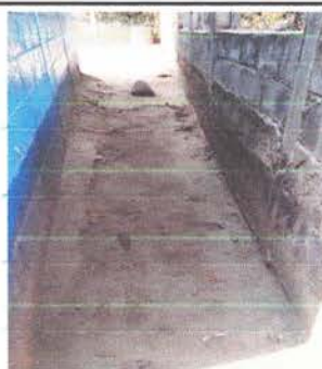
SUSTITUCIÓN DE PISO DE TORTA DE CONCRETO
