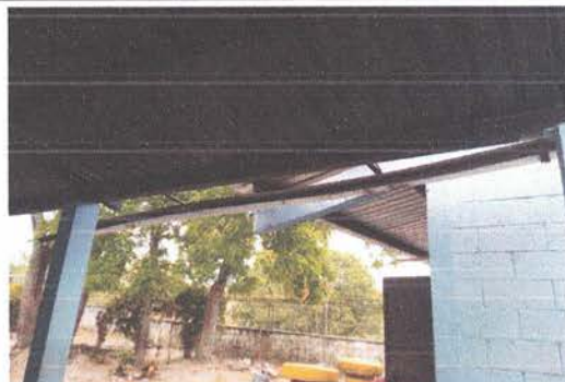
REPARACION DE CANALES DE AGUA PLUVIAL
