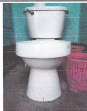
SUSTITUCIÓN DE SANITARIOS Y SUS ACCESORIOS
