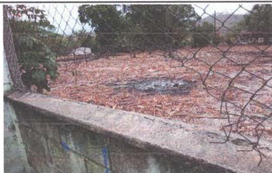
REPARACIÓN DE MURO PERIMETRAL
