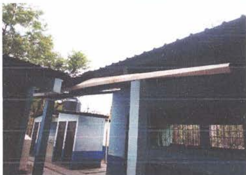
SUSTITUCIÓN DE CANALES DE AGUA PLUVIAL
