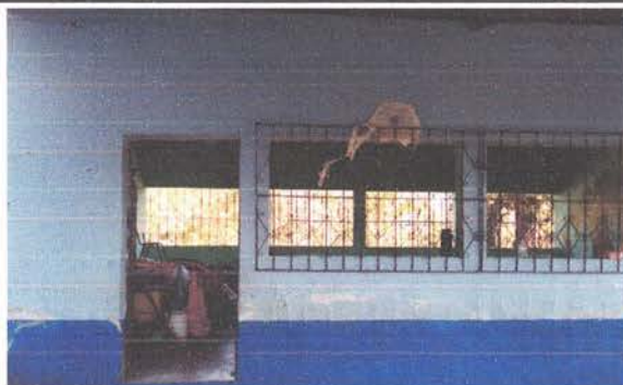
REPARACIÓN DE ESTRUCTURA DE BALCONES
