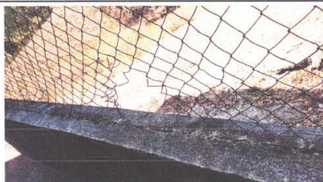
REPARACIÓN DE MURO PERIMETRAL
