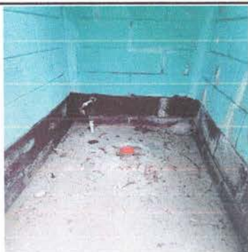
SUSTITUCIÓN DE SANITARIOS Y SUS ACCESORIOS
