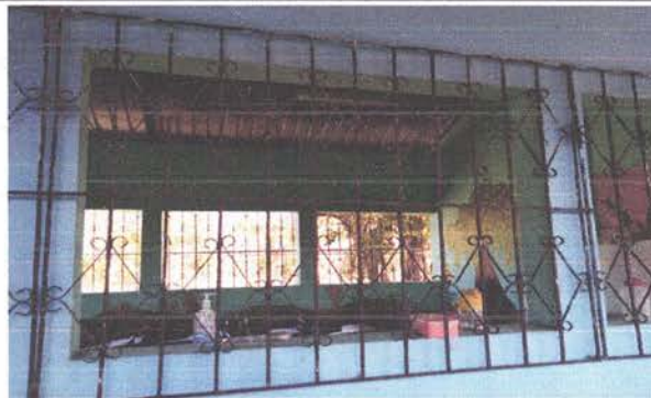
REPARACIÓN DE ESTRUCTURA DE BALCONES
