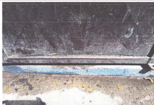
MANTENIMIENTO A PUERTAS DE METAL
