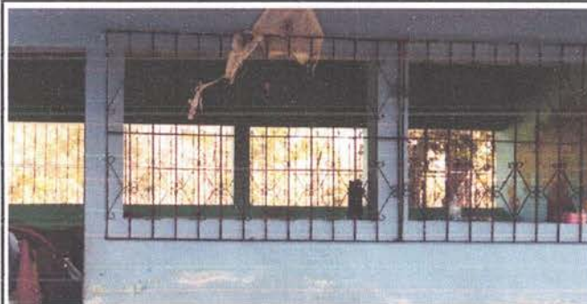
REPARACIÓN DE ESTRUCTURA DE BALCONES
