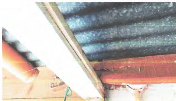
Foto 7: Sustrucción de estructura de soporte de madera por metal
