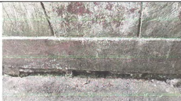
Foto 11: Sustrucción de paredes de block de las aulas con daños en la parte de afuera de las aulas
