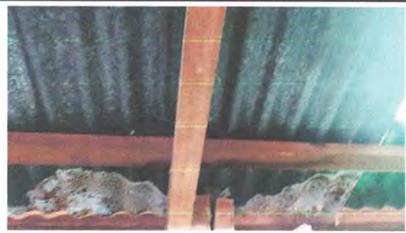
Foto 6: Sustitución de estructura de soporte de madera por metal
