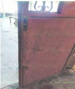
Foto 3: Mantenimiento a puertas de metal (Lijado, cepillado y pintado)
