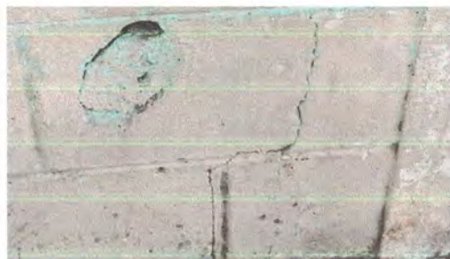
Foto 12: Sustrucción de paredes de block de las aulas con daños en la parte de afuera de las aulas
