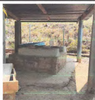
Foto 10: Sustrucción de estufa rural (Incluye polletón, chimenea y plancha de metal)
