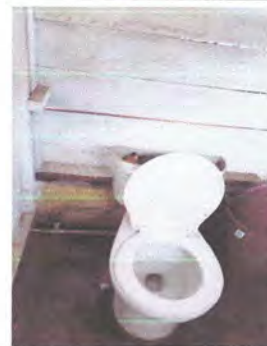
Foto 4: Sustitución de sanitarios con sus accesorios
