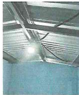
Foto 2: Sustitución e instalación del sistema electrico (Plafoneras)
