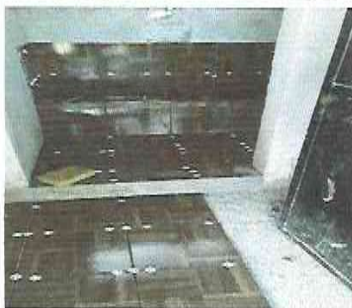
Foto 5: Sustitución de piso de torta de concreto por piso ceramico en el modulo de baños
