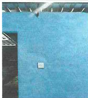
Foto 3: Sustitución e instalación del sistema electrico (Plafoneras y switch, cableado)
