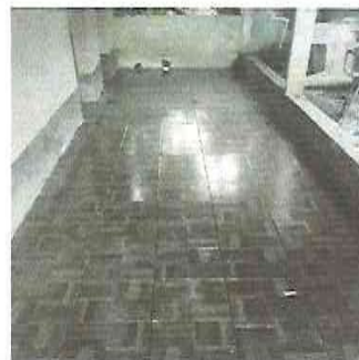
Foto 4: Sustitución de piso de torta de concreto por piso ceramico
