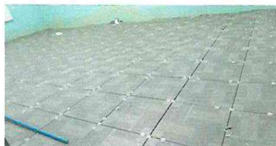
Foto 18: Sustitución de piso de torta de concreto por piso ceramico
