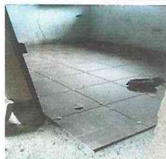
Foto 20: Sustitución de piso de torta de concreto por piso ceramico
