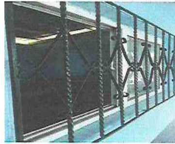
Foto 8: mantenimiento a balcones de metal (Lijado, Cepillado y Pintado)
