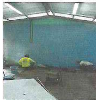
Foto 14: Pintura en muros interiores y exteriores
