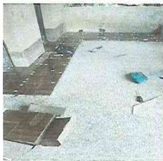
Foto 15: Sustitución de piso de torta de concreto por piso ceramico
