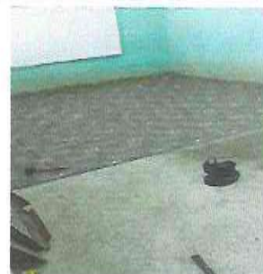
Foto 22: Sustitución de piso de torta de concreto por piso ceramico
