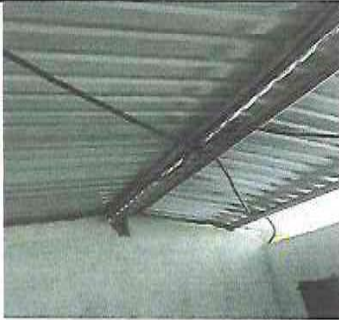
Foto 7: Sustitución de caleado flexitubo en el sistema electrico
