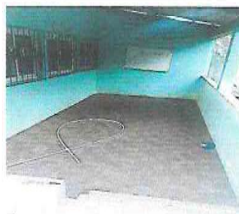
Foto 9: Sustitución de piso de torta de concreto por piso cerámico
