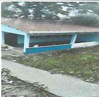
Foto 9: mantenimiento de láminas y aplicación de pintura
