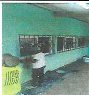
Foto 8: Pintura en muros interiores y exteriores
