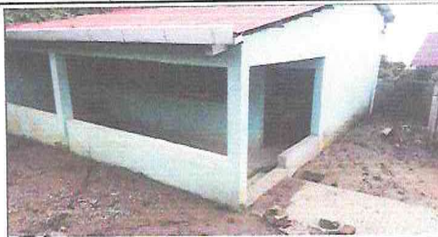
MANTENIMIENTO DE LÁMINA (APLICACIÓN DE PINTURA)
