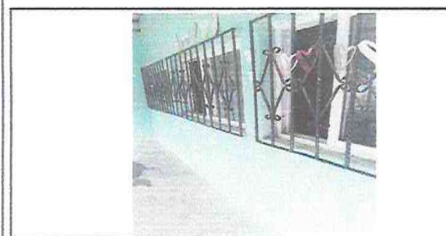
FOTO 14: MANTENIMIENTO A BALCONES DE METAL (LIJADO, CEPILLADO Y PINTURA)
