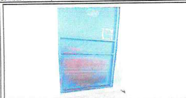
FOTO 12: SUSTITUCIÓN DE PUERTA DE METAL
