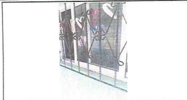
FOTO 13: MANTENIMIENTO A BALCONES DE METAL (LIJADO, CEPILLADO Y PINTURA)
