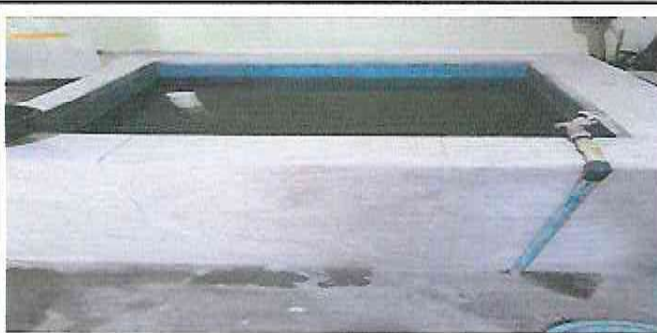
Foto 5: Sustitución de azulejo en pila del area de baños
