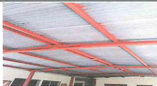
Foto 2: Mantenimiento a soporte de estructura metálica pintura
