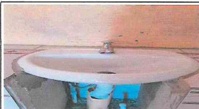
Foto 4: Sustitución de lavamanos
