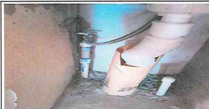
Foto1: Sustitución de tubería pvc red principal
