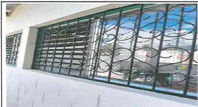
Foto 3: Mantenimiento a balcones de metal pintura
