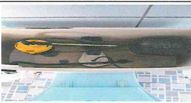
Foto 3: Sustitución de accesorios de inodoro
