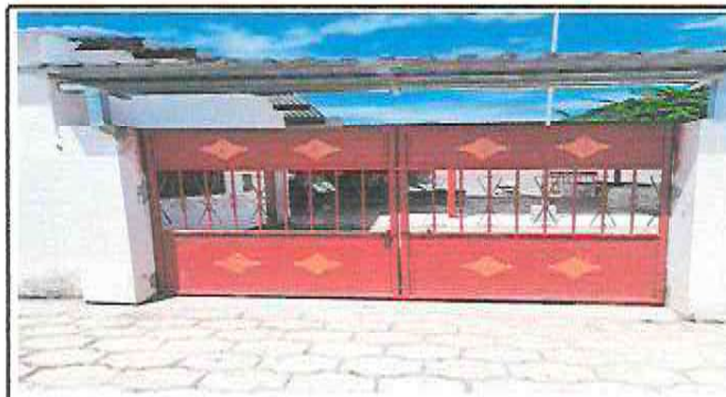
Foto 4: Sustitución de portón de metal
