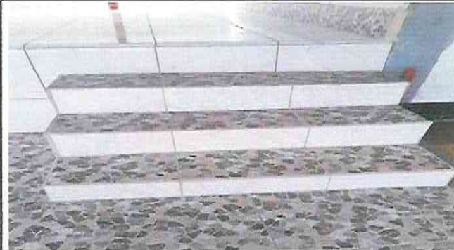
Foto 2: Ampliación de gradas del escenario
