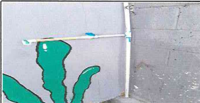
Foto 6: Sustitución de tubería para agua potable
