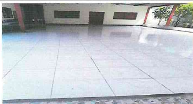
Foto 1: Sustitución de piso de torta a piso cerámico
