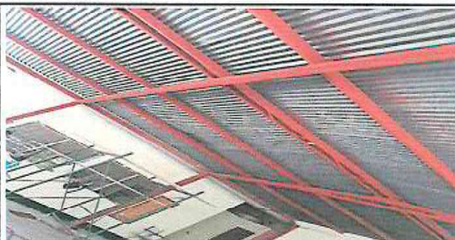
Foto 2: Mantenimiento a soporte de estructura metálica pintura
