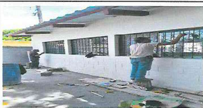
Foto 3: Mantenimiento a balcones de metal pintura
