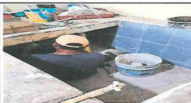
Foto 5: Sustitución de azulejo en pila del area de baños
