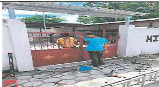
Foto 4: Sustitución de portón de metal
