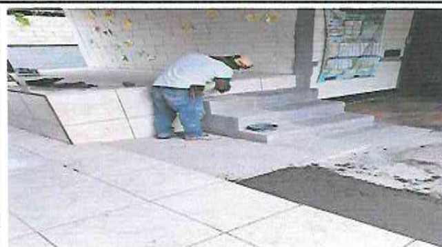
Foto 2: Ampliación de gradas del escenario
