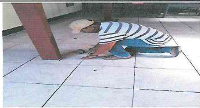
Foto1: Sustitución de piso de torta a piso ceramico
