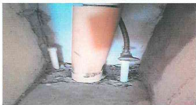
Foto1: Sustitución de tubería pvc red principal
