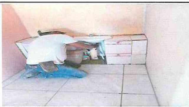
Foto 4: Sustitución de lavamanos
