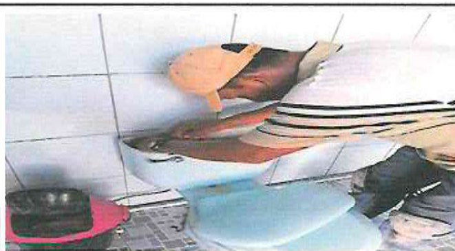
Foto 3: Sustitución de accesorios de inodoro
