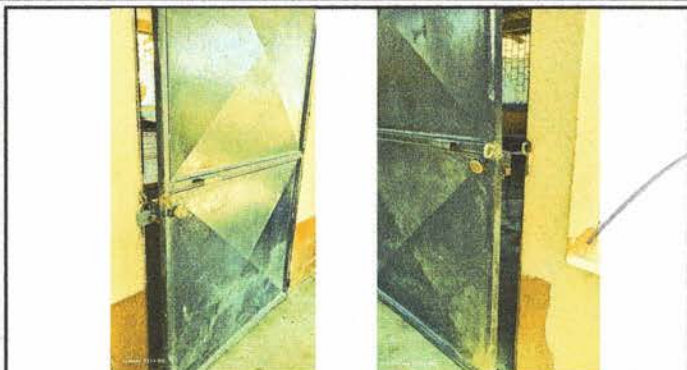
Foto 1: Se necesita mantenimiento de estructura en puertas y cambio de chapas
