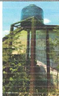
Foto 8: Se necesita instalacion de estructura portante de metal
