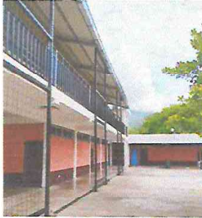
Foto 1: CONTINUIDAD VERTICAL DE BARANDA EN SEGUNDO NIVEL.
