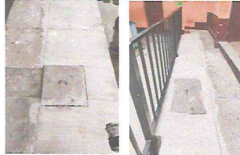
Foto 8:LEVANTADO DE BROCAL DE TAPADERAS DE CAJAS DE REGISTRO EN BANQUETAS.
