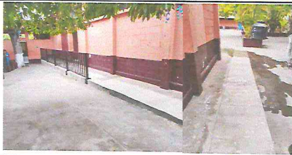
Foto 5: SUSTITUCION O INSTALACION DE PISO DE CONCRETO EN BANQUETA.
