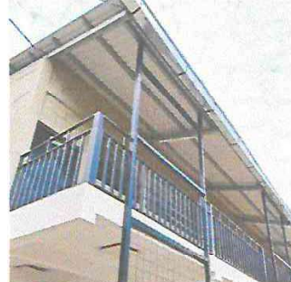
Foto 2: CONTINUIDAD VERTICAL DE BARANDA EN SEGUNDO NIVEL.
