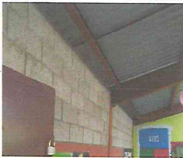
Foto 9: LEVANTADO DE MAMPOSTERIA REFORZADA.
