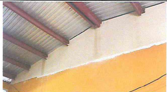
Foto 14: MURO TIPO MOJINETE SOBRE PARED EXISTENTE.
