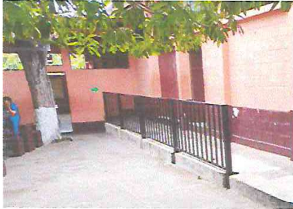
Foto 7: INSTALACION DE BARANDA METALICA.
