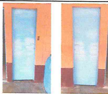
Foto 12: MANTENIMIENTO DE PUERTAS METALICAS.
