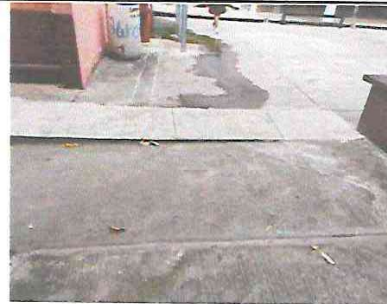
Foto 6: SUSTITUCION O INSTALACION DE PISO DE CONCRETO PARA RAMPA PEATONAL.
