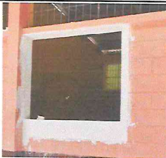
Foto 15: DEMOLICION DE MURO PARA VANO DE VENTANA.
