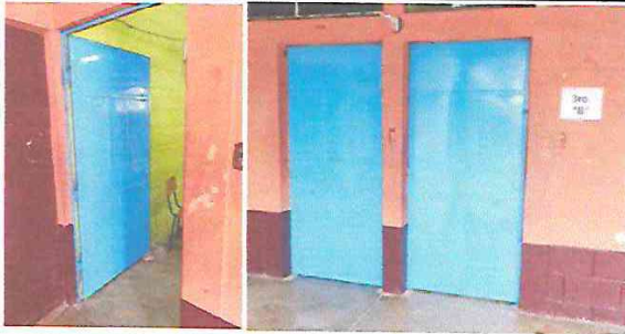
Foto 11: SUSTITUCION E INSTALACION DEPUERTAS DE METAL.
