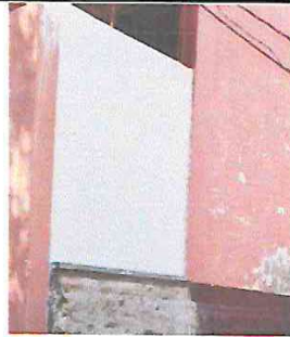
Foto 10:LEVANTADO DE MAMPOSTERIA REFORZADA.
