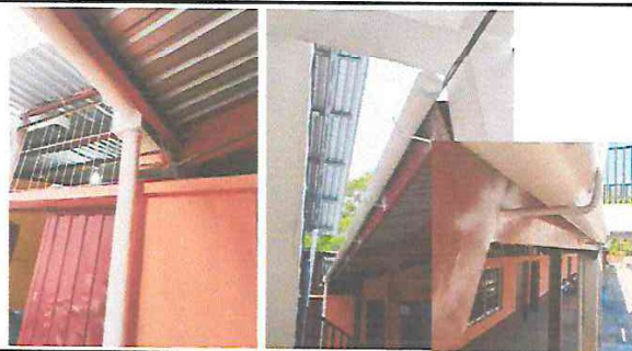
Foto 4: INSTALACION DE BAJADAS DE AGUA PLUVIAL DE TUBO PVC 3"
