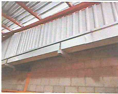
Foto 3: SUSTITUCION DE CANAL DE METAL.
