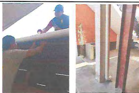
Foto 4: INSTALACION DE BAJADAS DE AGUA PLUVIAL DE TUBO PVC 3"
