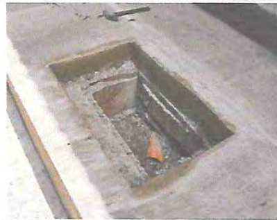
Foto 8: LEVANTADO DE BROCAL DE TAPADERAS DE CAJAS DE REGISTRO EN BANQUETAS.
