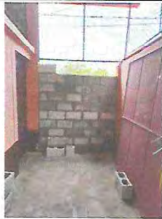
Foto 9: LEVANTADO DE MAMPOSTERIA REFORZADA.
