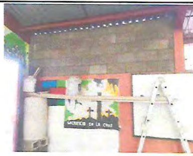
Foto 10: LEVANTADO DE MAMPOSTERIA REFORZADA.
