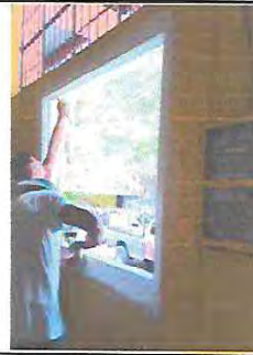
Foto 16: INSTALACION DE VENTANA PVC.
