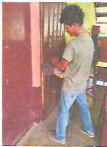
Foto 11: SUSTITUCION E INSTALACION DE PUERTAS DE METAL.
