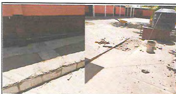
Foto 6: SUSTITUCION O INSTALACION DE PISO DE CONCRETO PARA RAMPA PEATONAL.
