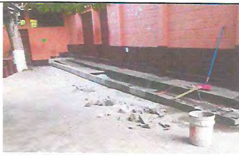
Foto 5: SUSTITUCION O INSTALACION DE PISO DE CONCRETO EN BANQUETA.
