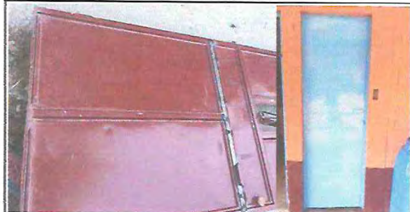
Foto 12: MANTENIMIENTO DE PUERTAS METALICAS.
