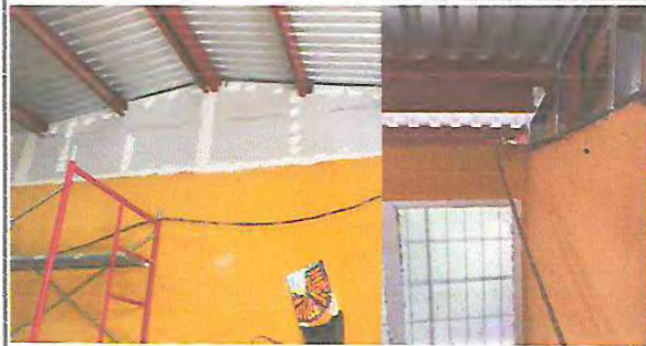
Foto 14: MURO TIPO MOJINETE SOBRE PARED EXISTENTE.
