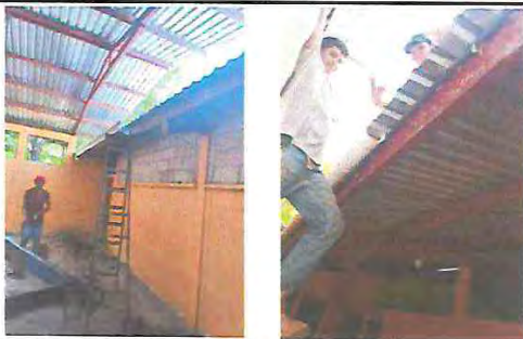
Foto 3: SUSTITUCION DE CANAL DE METAL.
