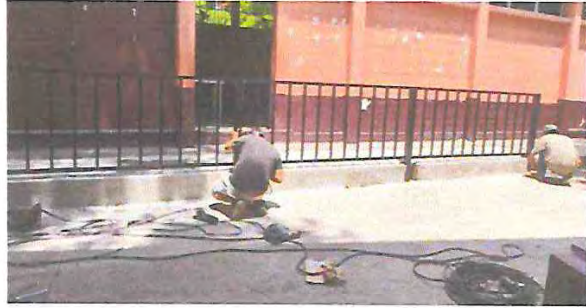
Foto 7: INSTALACION DE BARANDA METALICA.
