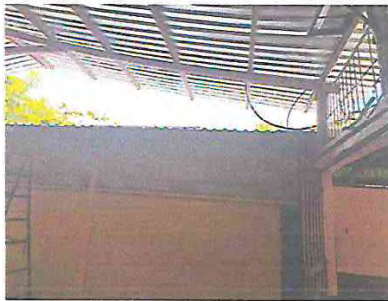
Foto 13: SELLADO DE MONJINETE CON LAMINA Y ESTRUCTURA METALICA.
