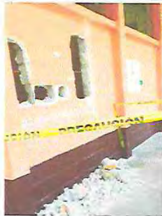
Foto 15: DEMOLICION DE MURO PARA VANO DE VENTANA.
