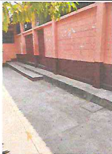
Foto 3: Instalacion de piso de torta de Concreto para banqueta y creacion de rampa, como tambien baranda metalica de seguridad.
