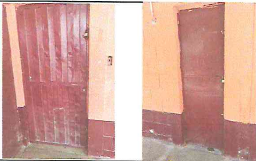
Foto 5: Sustitución y reparacion de puertas metalicas.
