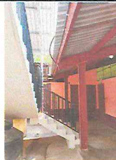
Foto 2: Instalación de canal y Bajadas de Agua pluvial.
