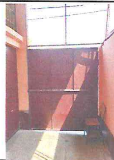
Foto 4: Cerrar vano con mampostería reforzada.
