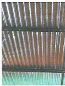
FOTOGRAFÍA No. 7 Pintura de estructura metálica de cancha
