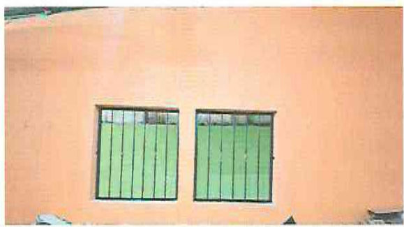
FOTOGRAFÍA No. 5 Pintura en muros
