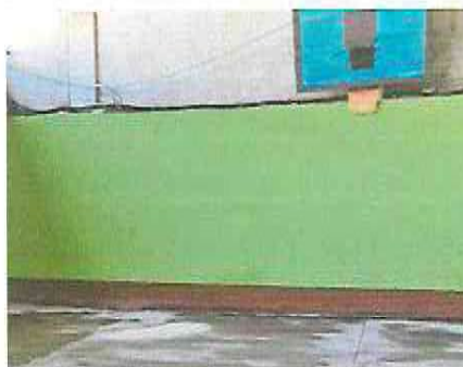
FOTOGRAFÍA No. 2 Reparación de muro de block
