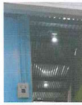
FOTOGRAFÍA No. 8 Instalación de sistema eléctrico
