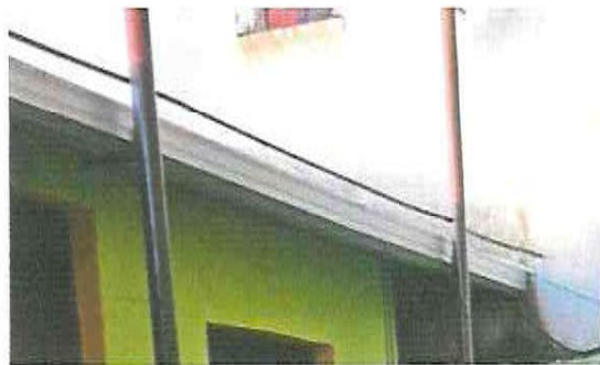
FOTOGRAFIA No. 4 Instalación de canal
