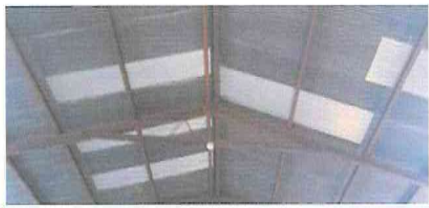
FOTOGRAFÍA No. 3 Sustitución de laminas
