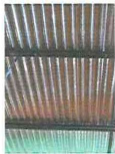
FOTOGRAFÍA No. 7 Pintura de estructura metálica de cancha
