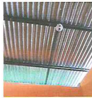
FOTOGRAFÍA No. 8 Instalación de sistema eléctrico
