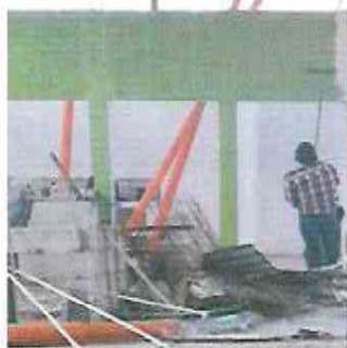
FOTOGRAFÍA No. 5 Pintura en muros
