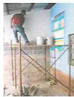
FOTOGRAFÍA No. 10 Repello y sanitización
