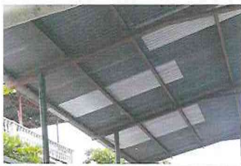
FOTOGRAFÍA No. 3 Sustitución de laminas
