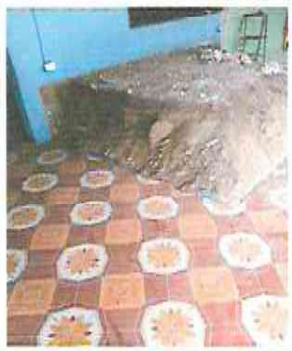
FOTOGRAFÍA No. 1 Demolición de escenario
