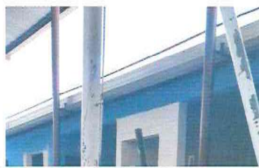
FOTOGRAFÍA No. 4 Instalación de canal
