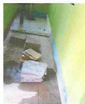
FOTOGRAFÍA No. 6 Instalación de piso cerámico
