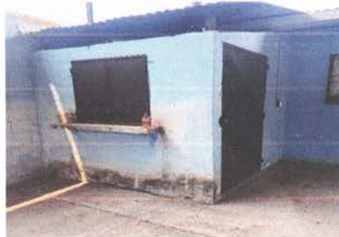
FOTOGRAFIA: REPELLO + SANITIZACION EN MUROS CERNIDO EN MUROS, PINTURA EN MUROS
