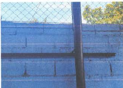
FOTOGRAFIA: REPELLO MAS SANITIZACION DE MUROS, CERNIDO EN MUROS, PINTURA EN MUROS.
