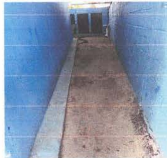
FOTOGRAFIA: INSTALACION DE PISO CERAMICO
