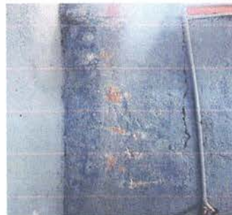
FOTOGRAFIA: REPELLO MAS SANITIZACION DE MUROS, CERNIDO EN MUROS, PINTURA EN MUROS.
