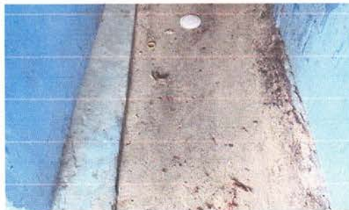
FOTOGRAFIA: INSTALACION DE PISO CERAMICO
