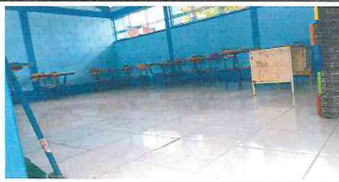
Foto 1: Piso cerámico colocada en interior de aula.
