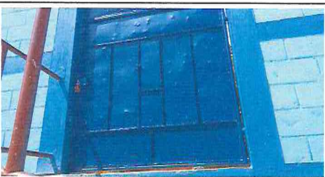
Foto 9: Mantenimiento finalizado a estructura (lijado, cepillado, sujeciones, aplicación de pintura) y cambio de chapa de puerta parte de enfrente de la escuela.
