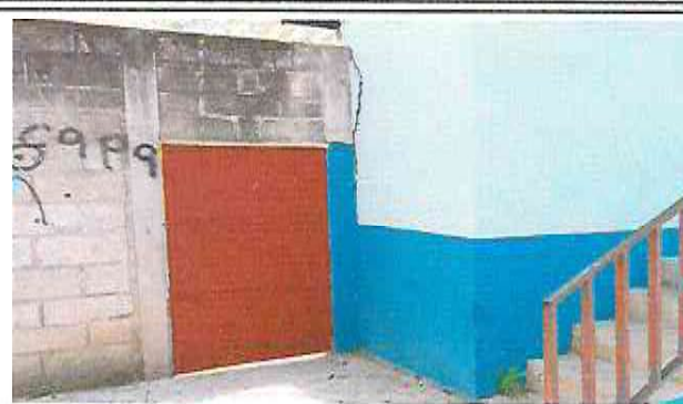
Foto 8: Mantenimiento finalizado a estructura (lijado, cepillado, sujeciones, aplicación de pintura) y cambio de chapa de puerta parte de atrás de la escuela.
