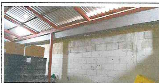
Foto 6: Reparación finalizada de soporte o pescante de metal para canal en dirección.
