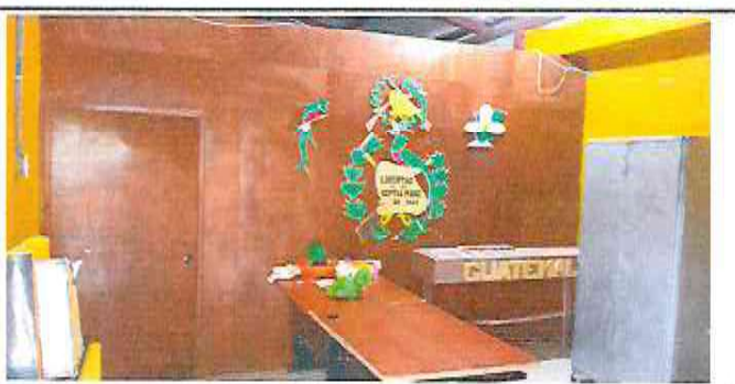
Foto 5: Instalación de módulo de madera en dirección.
