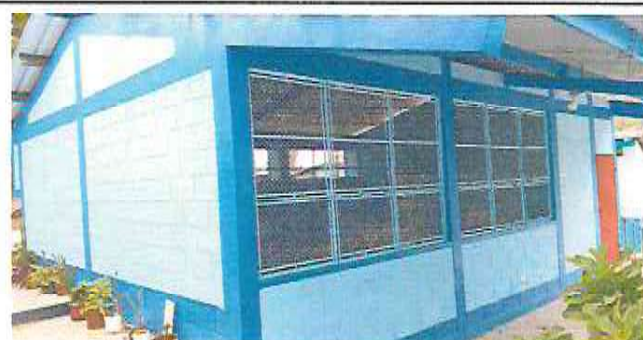
Foto 2: Estructuras de ventanas mejoradas con malla instalada en módulo de aula.
