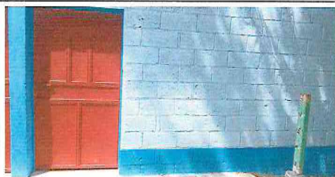
Foto 3: Mantenimiento finalizado a estructura (lijado, cepillado, sujeciones, aplicación de pintura) y cambio de chapa de puerta en módulo de dirección.
