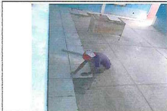
Foto 1: Proceso de colocación de piso cerámico para interior de aula.
