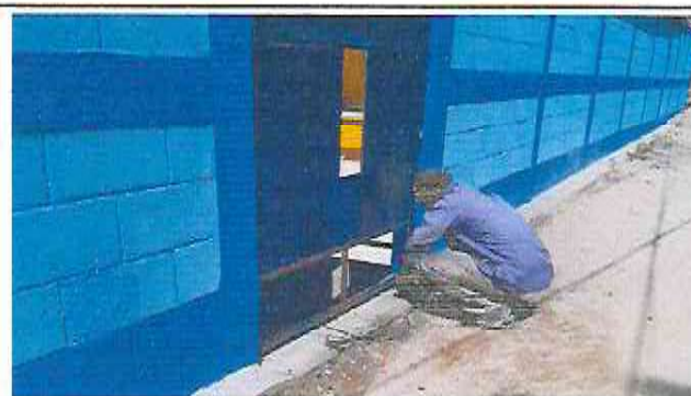
Foto 9: Proceso de mantenimiento a estructura (lijado, cepillado, sujeciones, aplicación de pintura) y cambio de chapa de puerta en parte de enfrente de la escuela.
