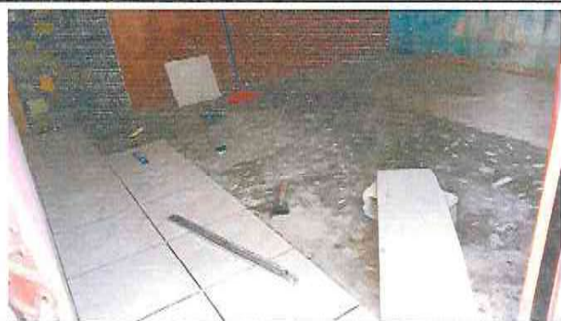
Foto 7: Proceso de nivelación de torta de cemento y colocación de piso cerámico para interior de dirección.
