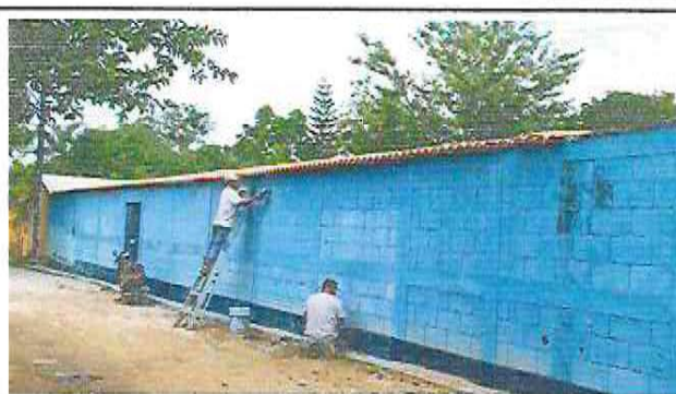
Foto 10: Pintando muros interiores y exteriores, escenario, aula, dirección y parte de enfrente de la escuela.
