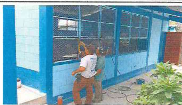
Foto 2: Proceso de mantenimiento a estructura de ventanas e instalación de malla en aula.
