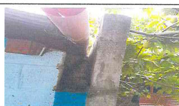
Foto 6: Reparación y sustitución de soporte o pescante de metal para canal en dirección.
