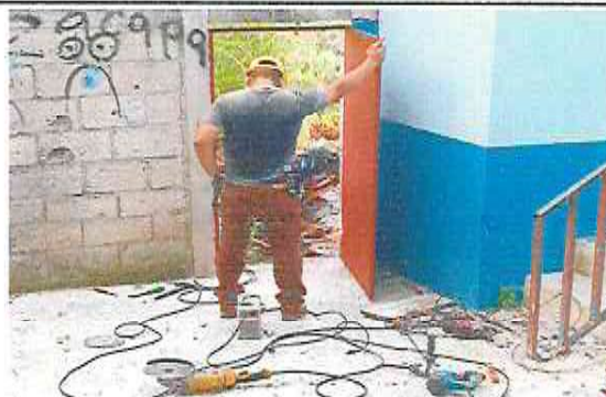
Foto 8: Proceso de mantenimiento a estructura (lijado, cepillado, sujeciones, aplicación de pintura) y cambio de chapa de puerta en parte de atrás de la escuela.
