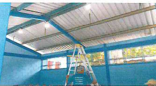
Foto 4: Inicio de sustitución de cableado eléctrico, sustitución interruptor, tomacorriente doble y sustitución de lámparas en dirección.
