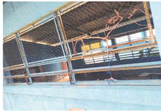
Foto 2: Mantenimiento a estructura de metal de ventana e instalación de malla en aula.
