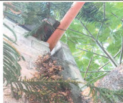
Foto 6: Sustitución de soporte o pescante de metal para canal en dirección.
