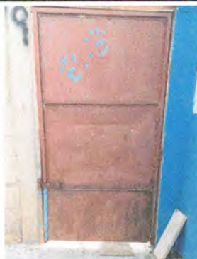
Foto 8: Mantenimiento a estructura de puerta (lijado, cambio de tubo, cepillado, sujeciones, aplicación de pintura) y cambio de chapa puerta parte de atrás de la escuela.
