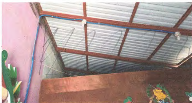
Foto 5: Sustitución e instalación de modulo de madera en dirección.
