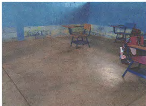
Foto 1: Colocación de piso cerámico para interior de aula.
