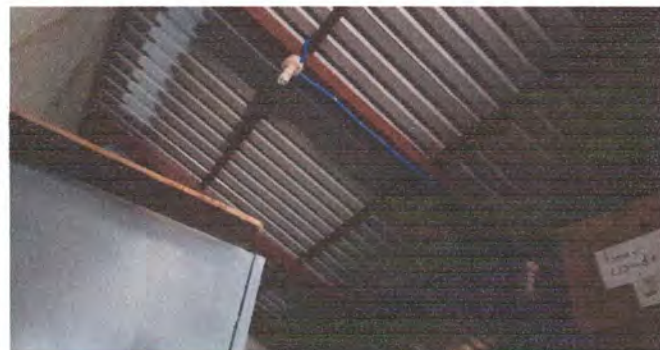
Foto 4: Sustitución cableado eléctrico, sustitución interruptor y tomacorriente doble y sustitución de lámparas en dirección.
