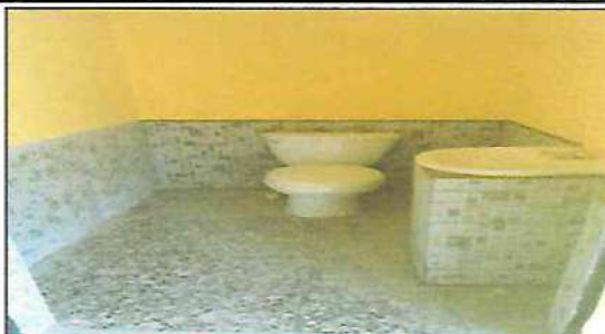
Foto 2: SUMINISTRO DE ZÓCALO DE AZULEJO ANTIDESLIZANTE EN BAÑOS
