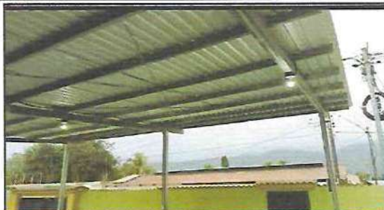
Foto 2: REPARACIÓN DE SISTEMA ELÉCTRICO EN ESCENARIO
