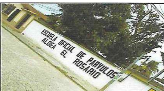
Foto 3: REPELLO EN MURO PRINCIPAL EXTERIOR E INTERIOR
