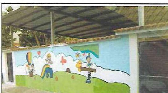
Foto 4: REPELLO EN MURO PRINCIPAL EXTERIOR E INTERIOR
