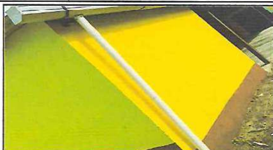
Foto 2: PINTURA EN MUROS EXTERIOR E INTERIOR
