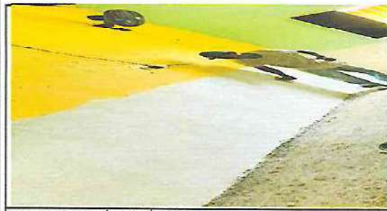
Foto 5: REPARACIÓN DE ZÓCALO EN AULA 1
