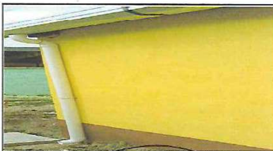
Foto 6: SUSTITUCIÓN DE CANAL Y SISTEMA DE BAJA PLUVIAL
