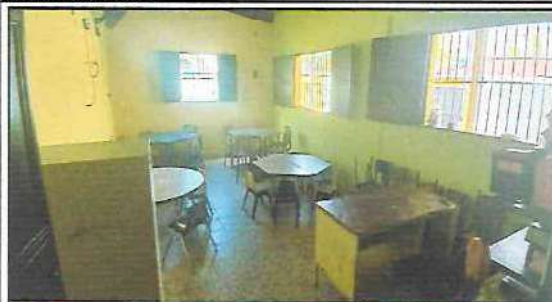
Foto 1: PINTURA EN MUROS EXTERIOR E INTERIOR
