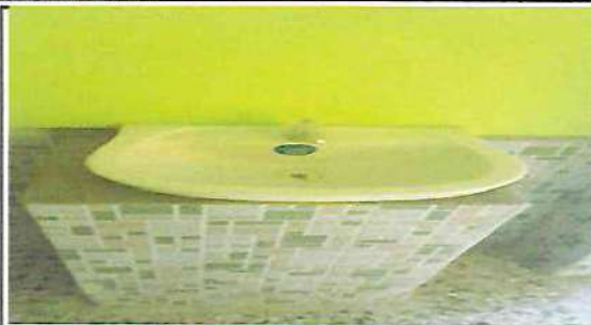
Foto 1: SUSTITUCIÓN DE LLAVE PARA LAVAMANOS
