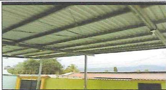
Foto 1: REPARACIÓN DE SISTEMA ELÉCTRICO EN ESCENARIO
