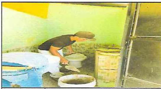
Foto 6: SUSTITUCIÓN DE ARTEFACTO SANITARIO INODORO
