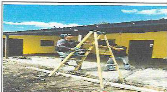
Foto 3: SUSTITUCIÓN DE CANAL Y SISTEMA DE BAJA PLUVIAL
