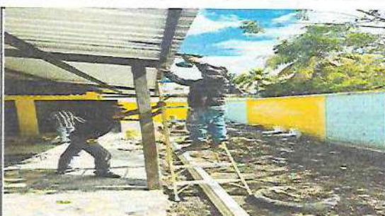
Foto 4: SUSTITUCION DE CANAL Y SISTEMA DE BAJA PLUVIAL
