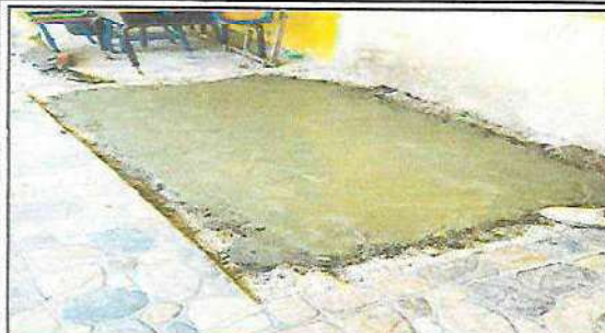
Foto 1: DEMOLICIÓN DE PILA EN MAL ESTADO Y CONSTRUCCIÓN DE NUEVA PILA
