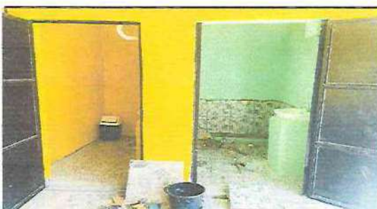
Foto 4: SUMINISTRO DE ZÓCALO DE AZULEJO ANTIDESLIZANTE EN BAÑOS
