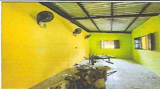
Foto1: PINTURA EN MUROS INTERIOR Y EXTERIOR
