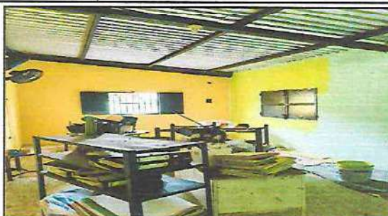
Foto 2: PINTURA EN MUROS INTERIOR Y EXTERIOR
