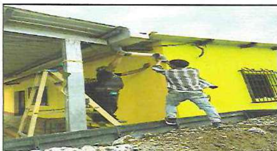
Foto 3: REPARACIÓN DE CANAL Y SISTEMA DE BAJADA PLUVIAL EN ESCENARIO
