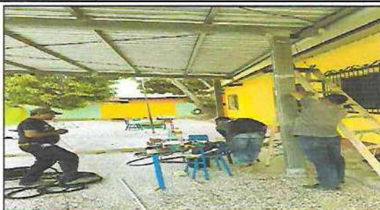
Foto 2: REPARACIÓN DE SISTEMA ELÉCTRICO EN ESCENARIO
