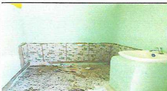
Foto 3: SUMINISTRO DE ZÓCALO DE AZULEJO ANTIDESLIZANTE EN BAÑOS
