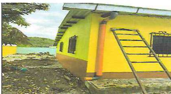
Foto 4: REPARACIÓN DE CANAL Y SISTEMA DE BAJADA PLUVIAL EN ESCENARIO
