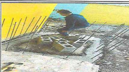
Foto 2: DEMOLICIÓN DE PILA EN MAL ESTADO Y CONSTRUCCION DE NUEVA PILA
