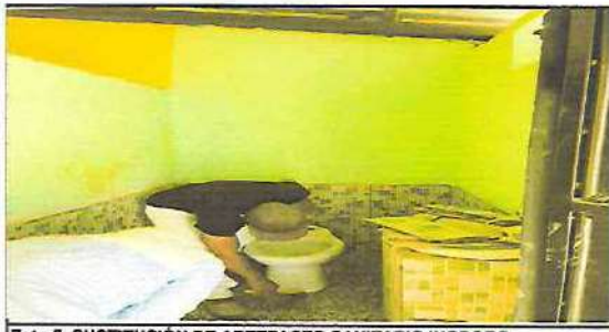
Foto 5: SUSTITUCIÓN DE ARTEFACTO SANITARIO INODORO
