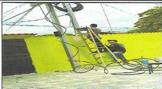
Foto 1: REPARACIÓN SISTEMA ELÉCTRICO EN ESCENARIO
