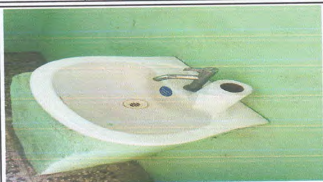
FOTOGRAFIA:SUSTITUCION DE LLAVE PARA LAVAMANOS
