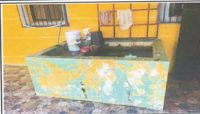
FOTOGRAFIA:DEMOLICION DE PILA EN MAL ESTADO
