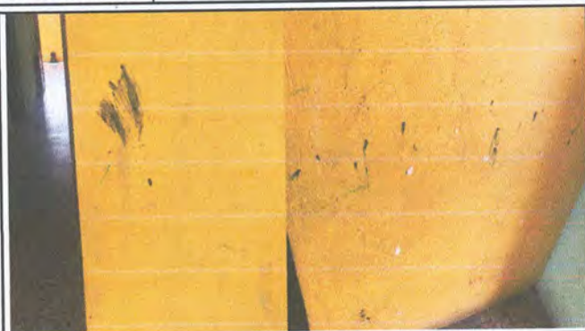
FOTOGRAFIA: PINTURA EN MUROS INTERIOR Y EXTERIOR
