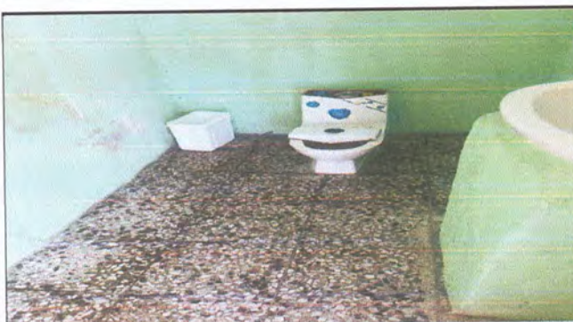
FOTOGRAFIA:SUMINISTRO DE ZOCALEO DE AZULEJO ANTIDESLIZANTE EN BAÑOS
