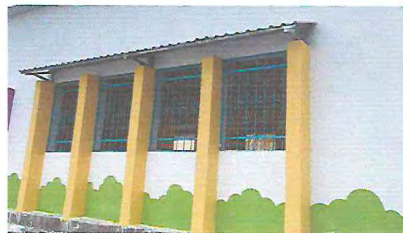
Foto 6. Repello, cernido y pintura en muro externo aula 2
