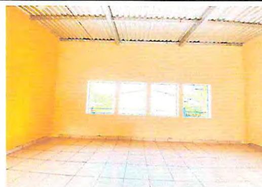
Foto 4. Repello, cernido y pintura en muro interno aula 2
