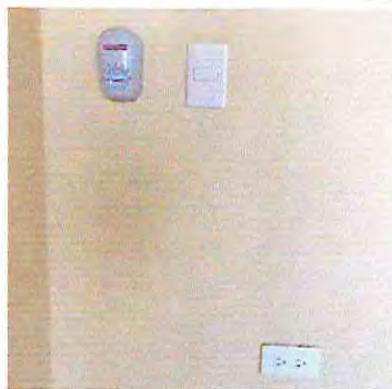
foto 11. Sustitución de tomacorrientes dobles
