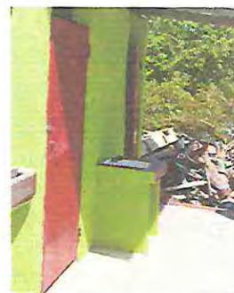
Foto 14. Sustitución de puertas de sanitario
