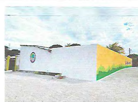
Foto 12. Repello, cernido y pintura de muro perimetral lado exterior y Reparación de muro perimetral de block
