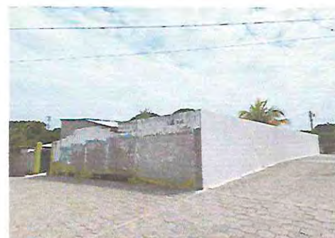
Foto 12. Repello, cernido y pintura de muro perimetral lado exterior y Reparación de muro perimetral de block
