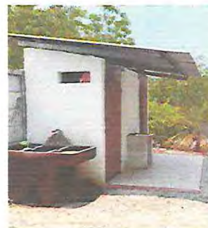
Foto 14. Sustitución de puertas de sanitario
