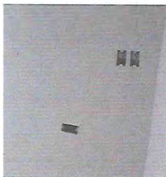
foto 11. Sustitución de tomacorrientes dobles
