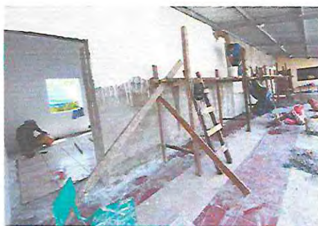
foto 5. Repello, cernido y pintura en muro externo aula 1
