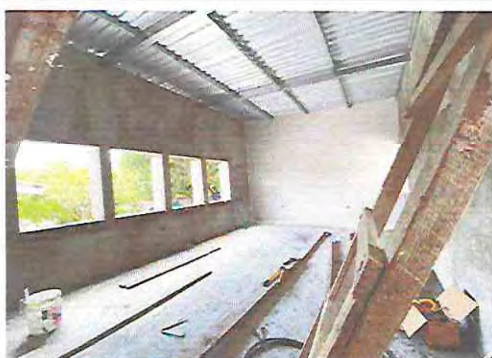
Foto 3. Repello, cernido y pintura en muro interno aula 1
