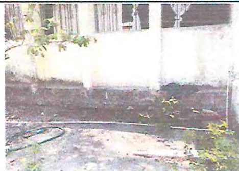
Foto 6. Repello, cernido y pintura en muro externo aula 2
