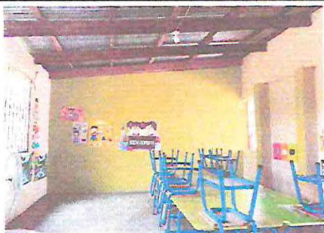
Foto 3. Repello, cernido y pintura en muro interno aula 1
