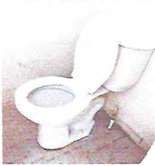
Foto 13. Sustitución de inodoro
