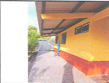
FOTOGRAFIA: PINTURA EN MUROS INTERIOR Y EXTERIOR EN MODULO DE AULAS
