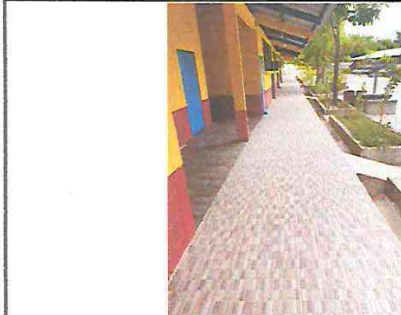
FOTOGRAFIA: SUSTITUCION DE PISO CERAMICO EN MODULO DE CORREDOR
