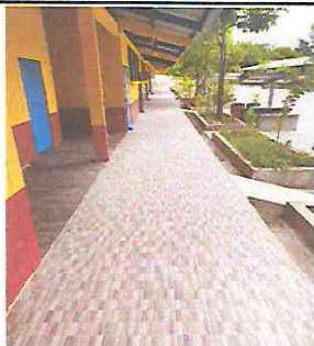
FOTOGRAFIA: PINTURA EN MUROS INTERIOR Y EXTERIOR EN MODULO DE AULAS
