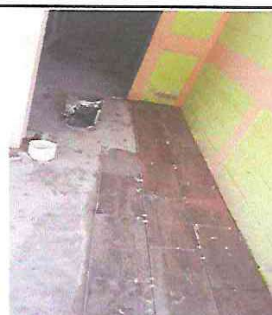
FOTOGRAFIA: SUSTITUCION DE PISO ANTIDESLIZANTE EN SANITARIO DE MUJERES
