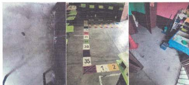
Foto 4. Sustitución de piso de torta de concreto
