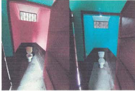
Foto 13. Sustitución de inodoros
