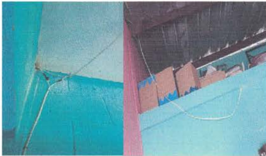
Foto 9. Reparación de cableado eléctrico
