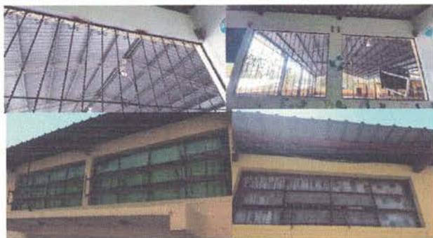
Foto 3. Sustitución de balcones de metal
