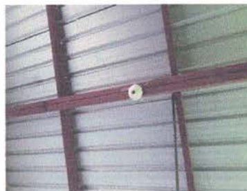
Foto 6. Sustitución de plafoneras
