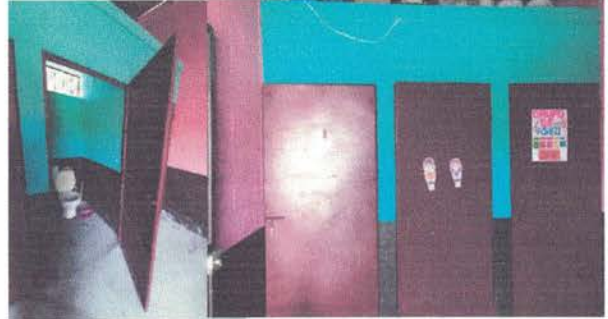
Foto 14. Reparación y sustitución de azulejo
