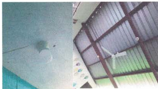
Foto 5. Sustitución de focos ahorradores
