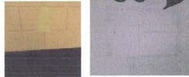
Foto 16. Pintura en muros exteriores e interiores
