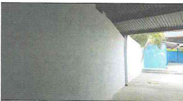
Foto 5: Suministro de repello en pared de cocina
