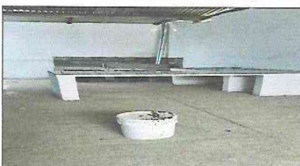
Foto 6: Suministro de repello en pared de cocina
