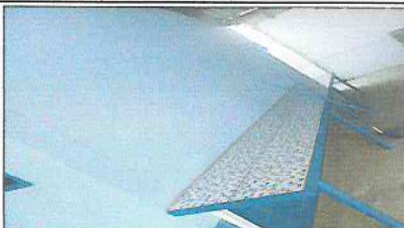
Foto 2: Suministro de mesa de concreto para alimentación escolar
