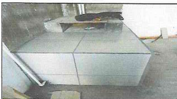
Foto 4: Instalación de azulejos en estufa rural
