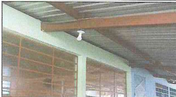
Foto 2: Reparación de cableado eléctrico, plafoneras, focos ahorradores
