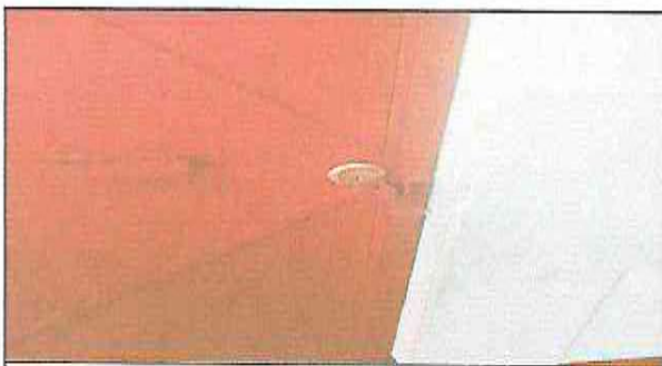
Foto 5: Suministro de chapas de puertas
