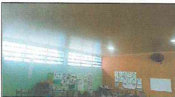
Foto 3: Pintura de paredes interior y exterior de dos aulas
