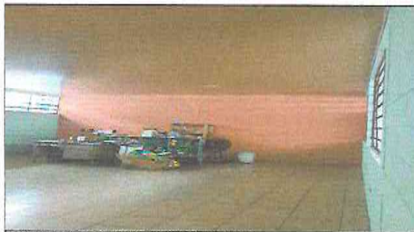
Foto 3: Pintura de Paredes interior y exterior
