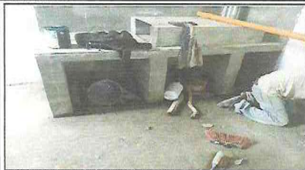
Foto 1: Sustrucción de chimenea de metal
