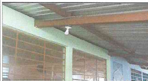
Foto 5: Reparación de cableado eléctrico
