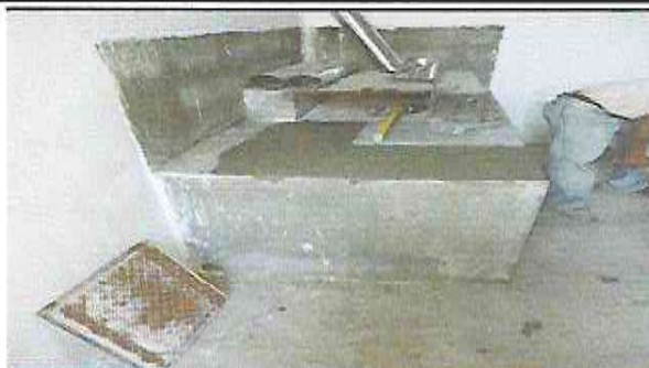
Foto 2: Sustitución de Chimenea de metal
