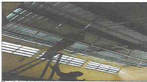
Foto 5: Suministro de Cielo falso
