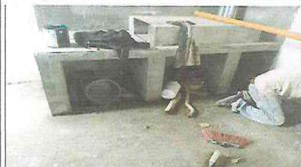
Foto 3: Sustitución de Chimenea de metal
