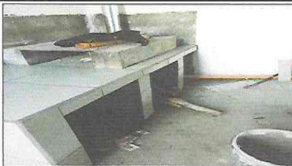
Foto 2: Instalación de azulejos en estufa rural
