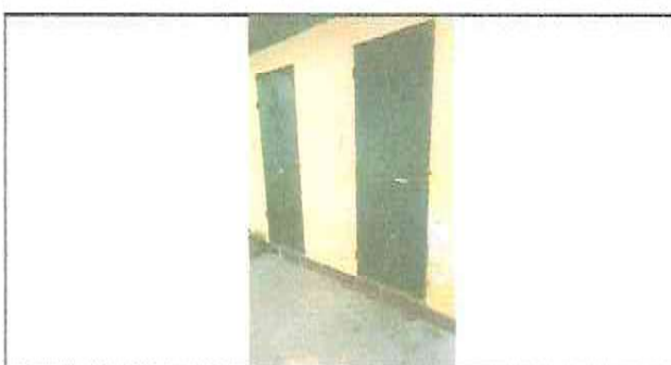
Foto 6: Pintura de baños
