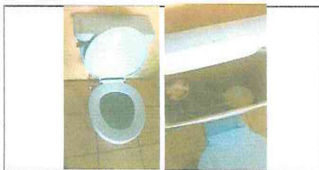
Foto 5: Sustitucion de accesorios y un inodoro, latex, tubo
