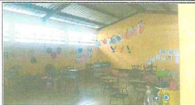
Foto1: Pintura de Paredes interior y exterior de dos aulas
