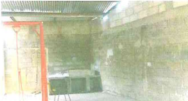
Foto 4: Suministro de repello en pared en cocina
