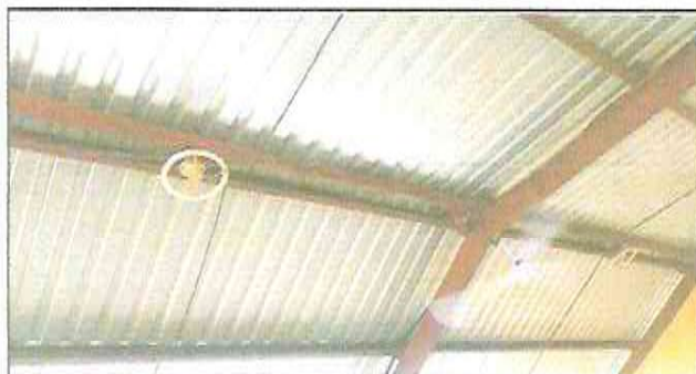
Foto 3: Suministro de cielo falso
