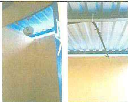
Foto 1: Reparación de cableado eléctrico de baños (Plafoneras, focos ahorradores)
