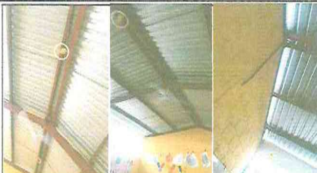
Foto 2: Reparacion de cableado electrico (sustitucion de plafoneras y lamparas led)
