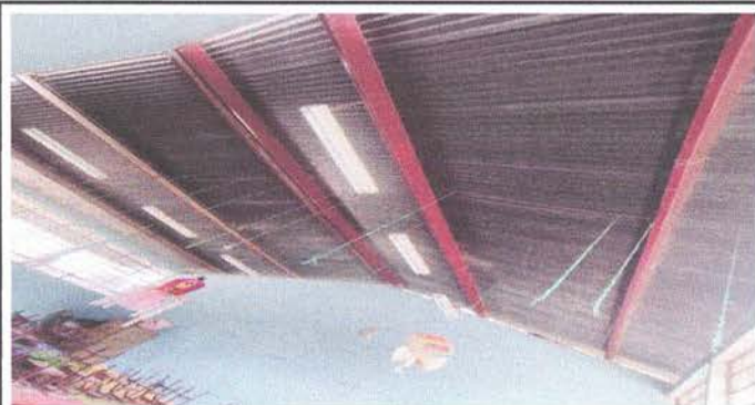
Foto 1: Sustitución de lamina, sustitución de elementos de fijación 1.1 y 1.3, 1.2
