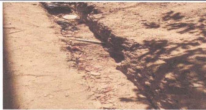
Foto 8: Instalacion de tuberia PVC 1/2" para habilitar servicio de tinaco.
