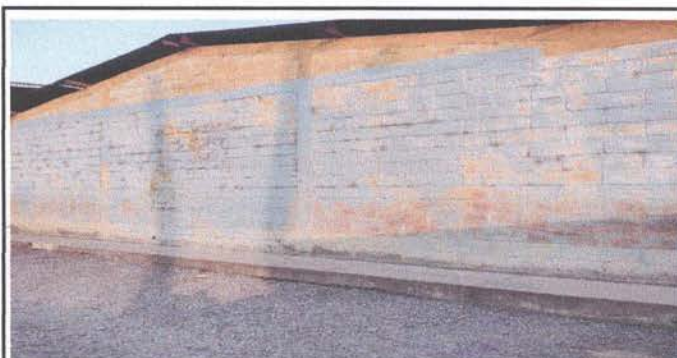
Foto 6: Pintura en muros exteriores e interiores. 9.1
