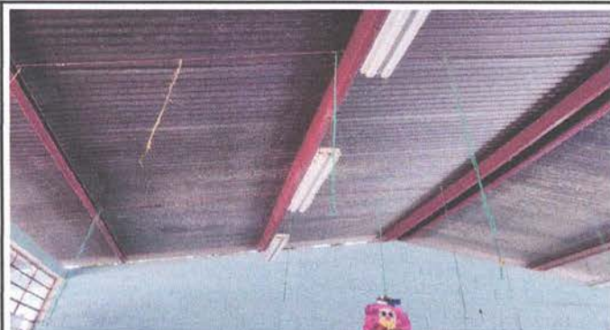
Foto 2: mantenimiento a estructura de soporte de metal. 2.1
