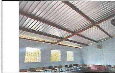
SUSTITUCION DE LAMINA, POR LAMINA TROQUELADA DE 18 PIES DE LARGO EN MODULO AULAS DE SEGUNDO A TERCERO
