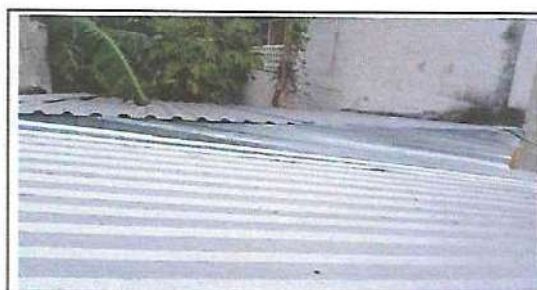
FOTOGRAFIA: REPARACION DE FILTRACION ENTRE LAMINA Y PARED MODULO COCINA
