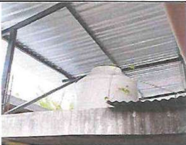
FOTOGRAFIA: TECHADO EN MODULO SERVICIOS SANITARIOS Y PILA
