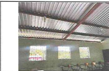
SUSTITUCION DE LAMINA, POR LAMINA TROQUELADA DE 12 PIES DE LARGO MODULO CORREDOR
