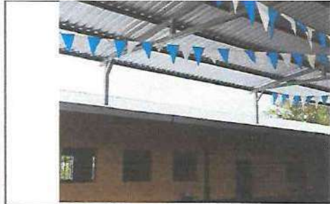
SUSTITUCION DE LAMINA, POR LAMINA TROQUELADA DE 18 PIES DE LARGO EN MODULO AULAS DE SEGUNDO A TERCERO
