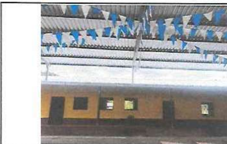
SUSTITUCION DE LAMINA, POR LAMINA TROQUELADA DE 12 PIES DE LARGO MODULO CORREDOR
