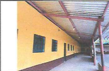
SUSTITUCION DE LAMINA, POR LAMINA TROQUELADA DE 18 PIES DE LARGO EN MODULO AULAS DE SEGUNDO A TERCERO
