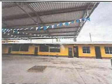
FOTOGRAFIA: SUSTITUCION DE CANAL METALICO EN MODULO DE AULAS DE CUARTO A SEXTO
