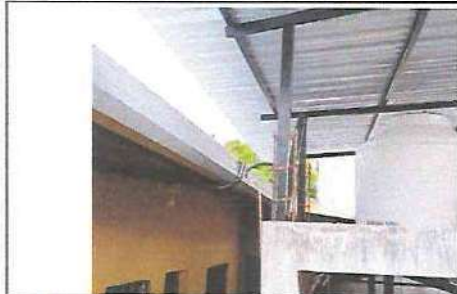
FOTOGRAFIA: SUSTITUCION DE CANAL METALICO EN MODULO DE ESCENARIO Y BAÑOS
