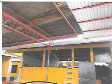
FOTOGRAFIA: SUSTITUCION DE BAJADA PLUVIAL EN MODULO DE AULAS DE CUARTO A SEXTO
