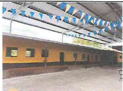
FOTOGRAFIA: SUSTITUCION DE CANAL METALICO EN MODULO DE AULAS DE TERCERO A SEGUNDO
