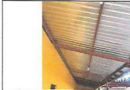
SUSTITUCION DE LAMINA, POR LAMINA TROQUELADA DE 12 PIES DE LARGO MODULO CORREDOR
