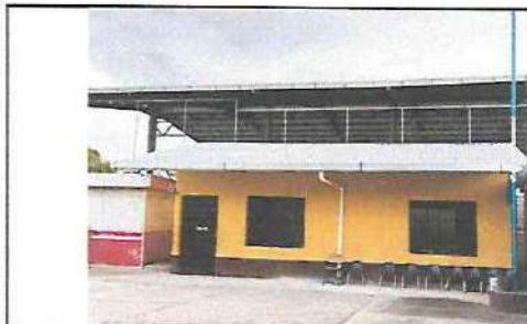
FOTOGRAFIA: SUSTITUCION DE CANAL METALICO EN MODULO AULA DE PRIMERO
