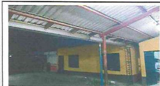
FOTOGRAFIA: SUSTITUCION DE CANAL METALICO EN MODULO AULA DE PRIMERO
