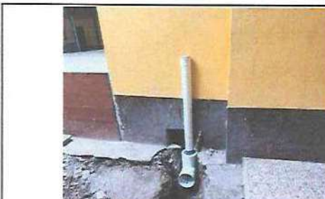
FOTOGRAFIA: SUSTITUCION DE BAJADA PLUVIAL EN MODULO DE AULAS DE CUARTO A SEXTO
