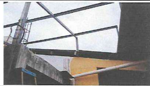
FOTOGRAFIA: TECHADO EN MODULO SERVICIOS SANITARIOS Y PILA
