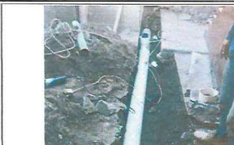
FOTOGRAFIA: SUSTITUCION DE BAJADA PLUVIAL EN MODULO DE ESCENARIO Y BAÑOS
