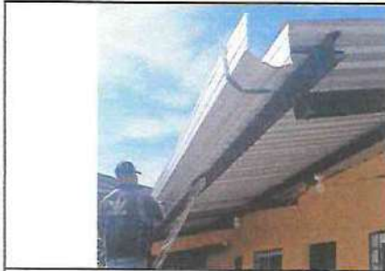
FOTOGRAFIA: SUSTITUCION DE CANAL METALICO EN MODULO DE AULAS DE TERCERO A SEGUNDO
