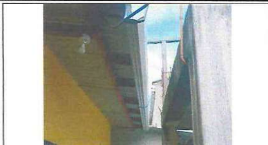
FOTOGRAFIA: SUSTITUCION DE CANAL METALICO EN MODULO DE ESCENARIO Y BAÑOS
