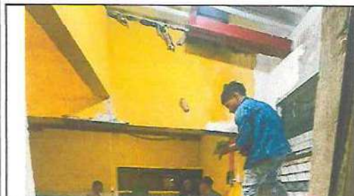
FOTOGRAFIA: REPARACION DE FILTRACION ENTRE LAMINA Y PERED MODULO COCINA
