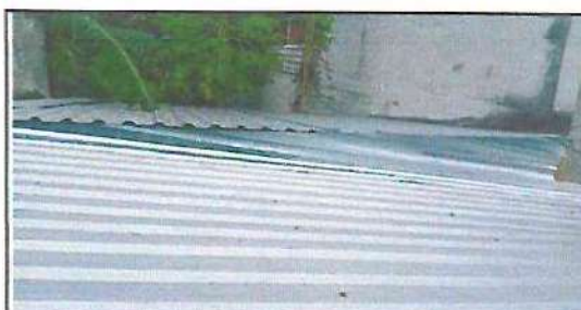
FOTOGRAFIA: REPARACION DE FILTRACION ENTRE LAMINA Y PERED MODULO COCINA
