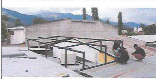
FOTOGRAFIA: TECHADO EN MODULO SERVICIOS SANITARIOS Y PILA
