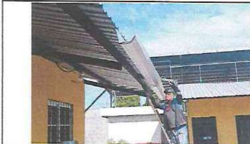
FOTOGRAFIA: SUSTITUCION DE CANAL METALICO EN MODULO DE AULAS DE CUARTO A SEXTO
