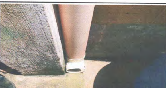
FOTOGRAFIA: SUSTITUCION DE BAJADA PLUVIAL EN MODULO DE AULAS DE CUARTO A SEXTO
