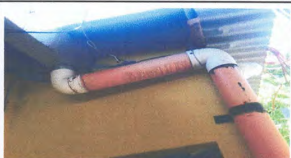
FOTOGRAFIA: SUSTITUCION DE BAJADA PLUVIAL EN MODULO DE AULAS DE SEGUNDO A TERCERO
