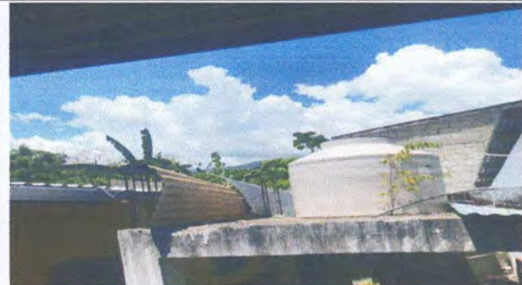
FOTOGRAFIA: TECHADO EN MODULO SERVICIOS SANITARIOS Y PILA
