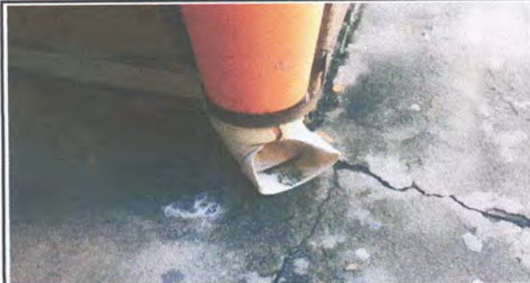
FOTOGRAFIA: SUSTITUCION DE BAJADA PLUVIAL EN MODULO DE ESCENARIO Y BAÑOS
