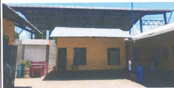
FOTOGRAFIA: SUSTITUCION DE CANAL METALICO EN MODULO AULA DE PRIMERO
