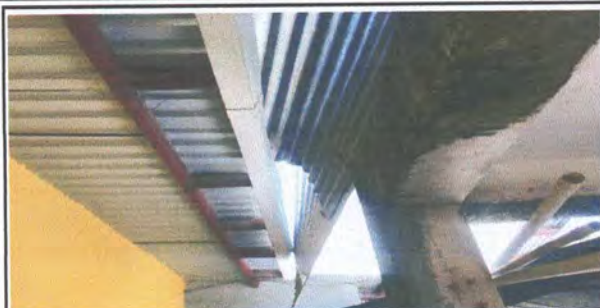
FOTOGRAFIA: SUSTITUCION DE CANAL METALICO EN MODULO DE ESCENARIO Y BAÑOS
