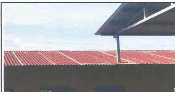
SUSTITUCION DE LAMINA, POR LAMINA TROQUELADA DE 12 PIES DE LARGO MODULO CORREDOR
