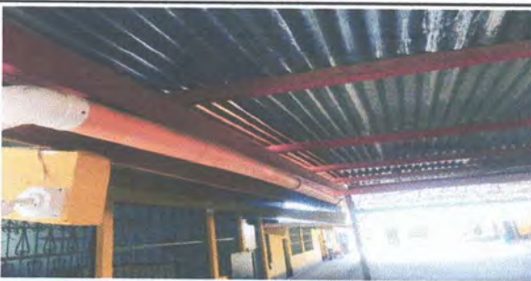
FOTOGRAFIA: SUSTITUCION DE CANAL METALICO EN MODULO DE AULAS DE CUARTO A SEXTO
