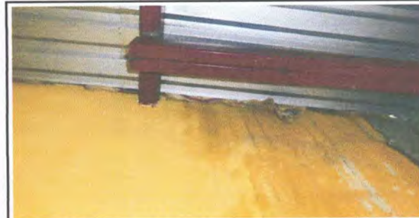
FOTOGRAFIA: REPARACION DE FILTRACION ENTRE LAMINA Y PARED MODULO COCINA
