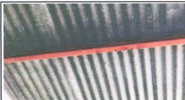
SUSTITUCION DE LAMINA, POR LAMINA TROQUELADA DE 18 PIES DE LARGO EN MODULO AULAS DE SEGUNDO A TERCERO
