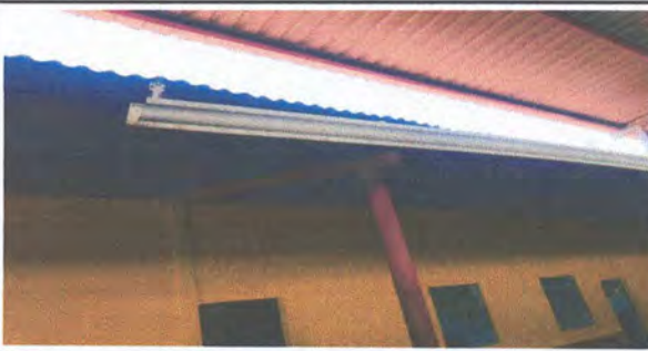
FOTOGRAFIA: SUSTITUCION DE CANAL METALICO EN MODULO DE AULAS DE SEGUNDO A TERCERO
