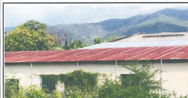
SUSTITUCION DE LAMINA, POR LAMINA TROQUELADA DE 18 PIES DE LARGO EN MODULO AULAS DE SEGUNDO A TERCERO
