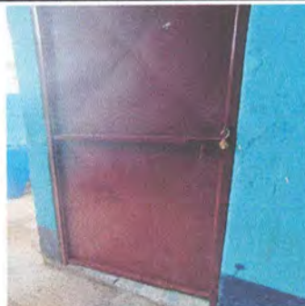
SUSTITUCIÓN DE PUERTAS DE METAL
