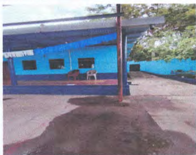
SUSTITUCIÓN DE CANAL DE METAL
