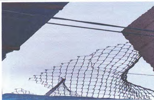
INSTALACIÓN DE MALLA GALVANIZADA EN MURO PERIMETRAL
