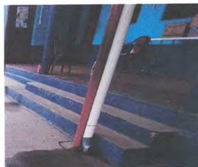
SUSTITUCIÓN DE BAJANTES DE AGUA PLUVIAL
