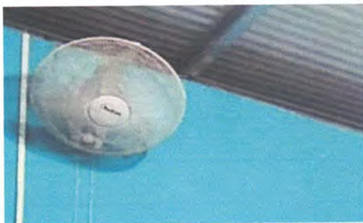
MANTENIMIENTO DE VENTILADORES
