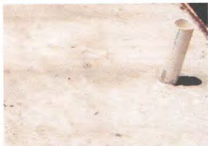
MANTENIMIENTO Y VACIADO DE FOSA SEPTICA
