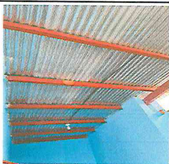
Foto 3: MANTENIMIENTO DE ESTRUCTURA METALICA, LIJADO Y PINTURA
