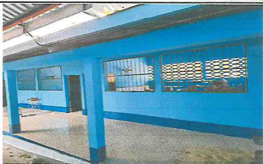
Foto 1: DEMOLICION DE CELOSILLA
