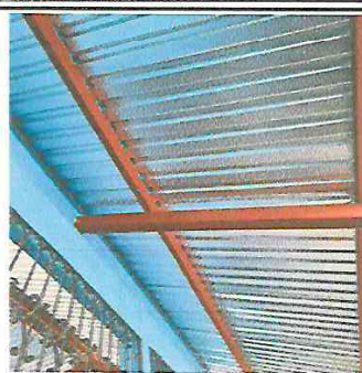
Foto 2: SUSTITUCION DE LAMINA
