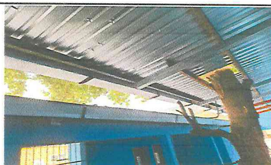
Foto 4: COLOCACION DE CANAL PARA AGUA PLUVIAL
