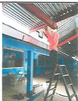
Foto 3: MANTENIMIENTO DE ESTRUCTURA METALICA, LIJADO Y PINTURA
