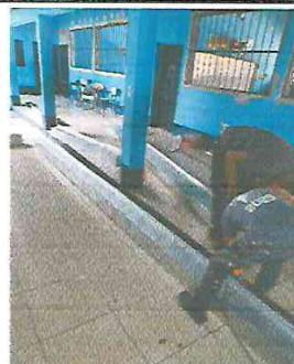
Foto 4: COLOCACION DE CANAL PARA AGUA PLUVIAL
