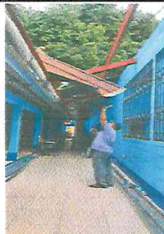
Foto 2: SUSTITUCION DE LAMINA
