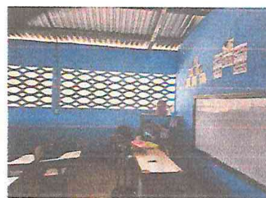
Foto 6: Resanado en paredes y cerramiento.
