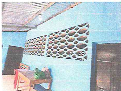
Foto 1: Demolición de celosilla
