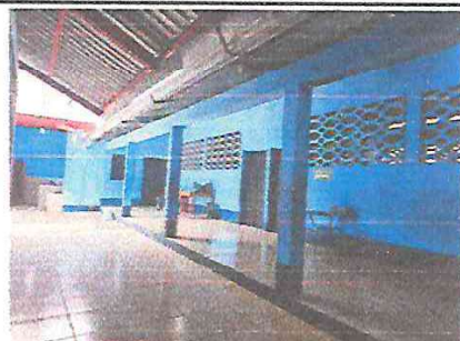
Foto 5: Colocación de ventanas y balcones.
