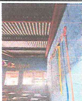
Foto 3: Mantenimiento a estructura metálica, lijado y pintura.
