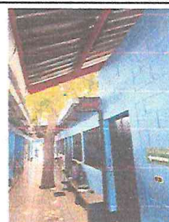
Foto 4: Colocación de canal para agua pluvial.
