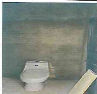
FOTO 9. REPELLO Y CERNIDO EN MUROS DE BAÑOS
