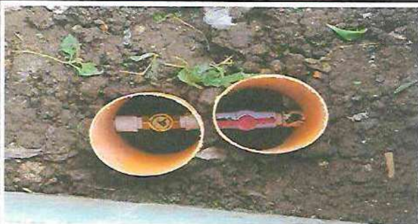
FOTO 7. CAMBIO DE LLAVE DE CHEQUE AL DEPOSITO DE AGUA
