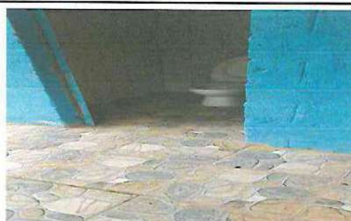
FOTO 4. SUMINISTRO E INSTALACIÓN DE AZULEJO EN BAÑOS h=1.50m
