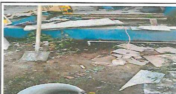
FOTO 6. SUSTITUCIÓN DE TUBERÍA LINEAL PRINCIPAL
