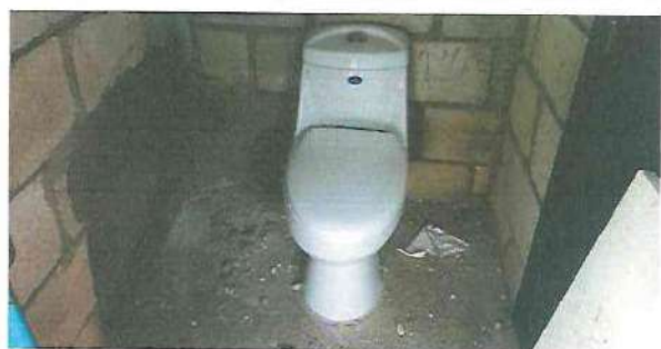
FOTO 9. REPELLO Y CERNIDO EN MUROS DE BAÑOS
