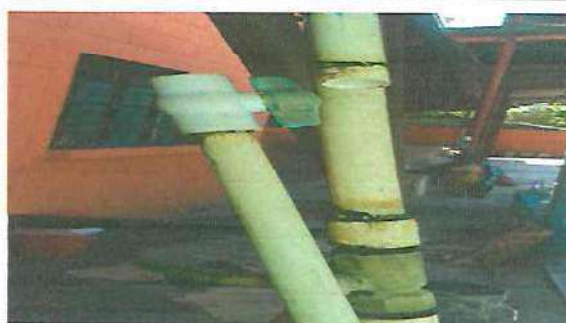
FOTO 8. SUSTITUCION ACCESORIOS DEPOSITO DE AGUA
