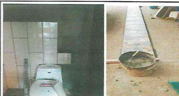
FOTO 4. SUMINISTRO E INSTALACIÓN DE AZULEJO EN BAÑOS h=1.50m
