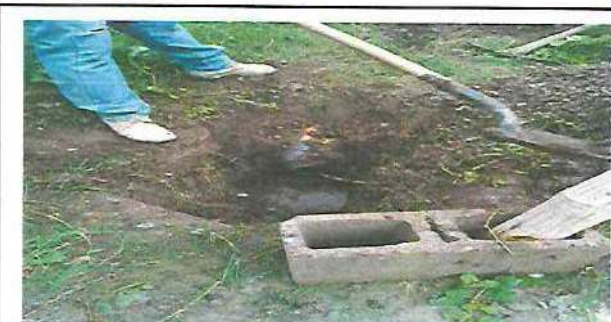
FOTO 5. MANTENIMIENTO DE REPOSADERA FOSA
