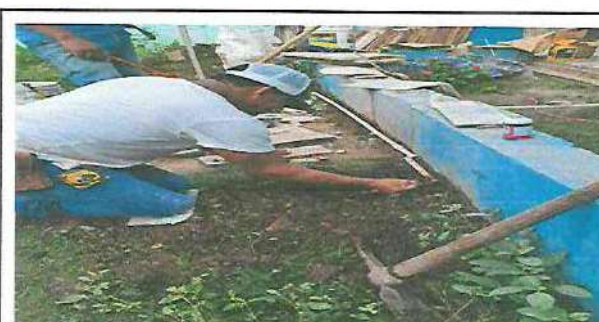
FOTO 6. SUSTITUCIÓN DE TUBERÍA LINEAL PRINCIPAL
