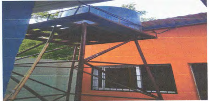
FOTO 8. SUSTITUCION ACCESORIOS DEPOSITO DE AGUA
