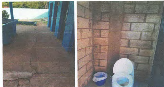
FOTO 4. SUMINISTRO E INSTALACIÓN DE AZULEJO EN BAÑOS h=1.50m
