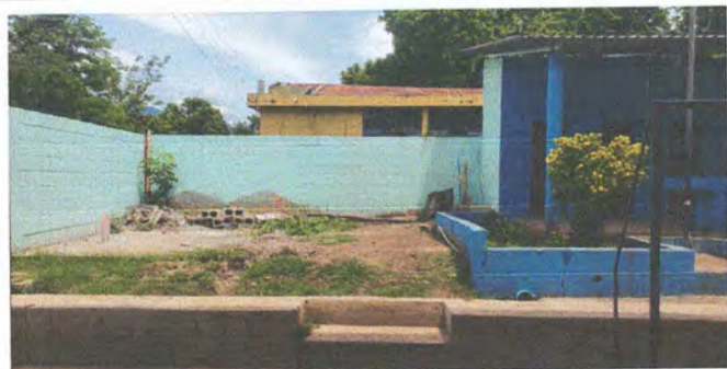
FOTO 5. MANTENIMIENTO DE REPOSADERA FOSA
