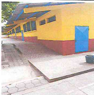
FOTOGRAFIA: PINTURA EN MUROS INTERIOR Y EXTERIOR EN MÓDULO DE AULAS
