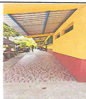
FOTOGRAFIA: SUSTITUCIÓN DE PISO CERÁMICO DE MÓDULO DE CORREDOR
